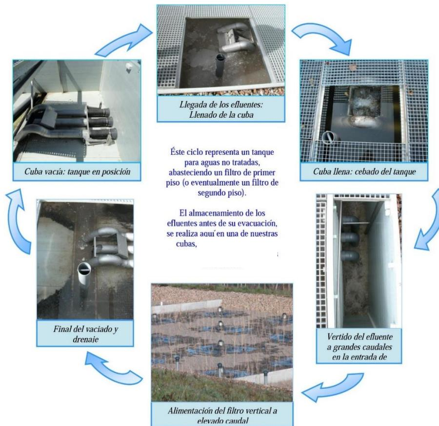
*Nota.* La figura representa el segundo componente de un sistema para tratar aguas servidas que es una cámara de distribución con un tanque pendular que se acciona de manera automática sin ningún aporte de energía. Imagen disponible en <http://www.alistep.com/tanques-pendulares/?lang=es>.
