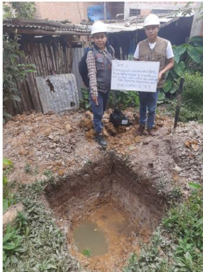
FOTOGRAFIA 01: Muestra la ubicación y estratigrafía, De La Calicata C - 1, de la Tesis: "Diseño Sismorresistente De La Subestructura De Una Vivienda Multifamiliar Con Presencia De Suelos Saturados Del Sector III – San Ignacio - Cajamarca".
