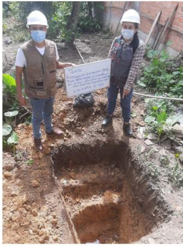
FOTOGRAFIA 02: Muestra la ubicación y estratigrafía, De La Calicata C - 2, de la Tesis: "Diseño Sismorresistente De La Subestructura De Una Vivienda Multifamiliar Con Presencia De Suelos Saturados Del Sector III – San Ignacio - Cajamarca".
