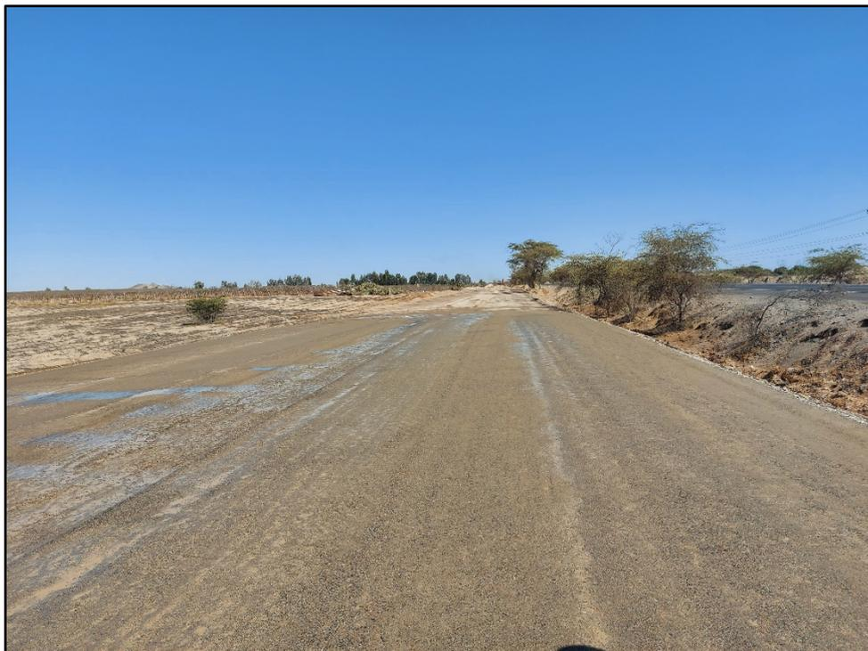
*Figura 27.* Vista del material de sub-base regado y compactado.
