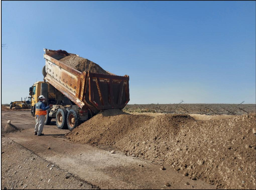
*Figura 24.* Acopio del material para relleno en la plataforma utilizando volquete.
