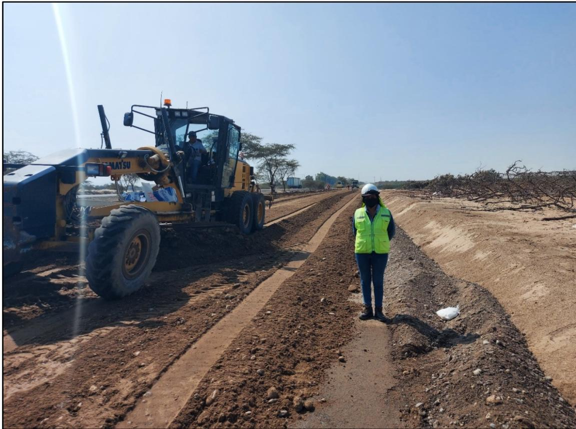
*Figura 15.* Nivelación de material de relleno utilizando motoniveladora, según la clasificación del SUCS el material de relleno es GW (Grava bien gradada, mezclas gravosas, poco o ningún fino).
