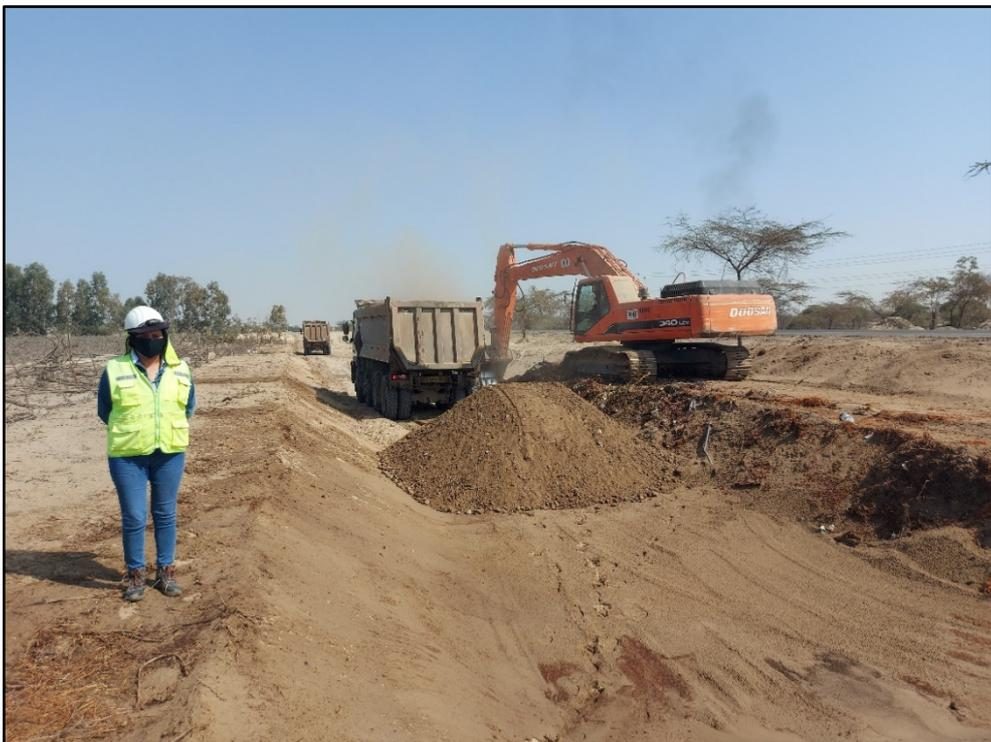
*Figura 23.* Carguío y eliminación de material con el uso de volquete y excavadora sobre oruga.
