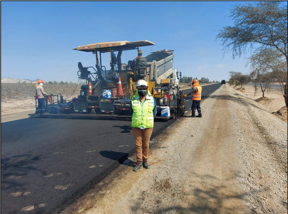
*Figura 19.* Vista del colocado de la primera capa de la mezcla de asfalto en caliente con pavimentadora.
