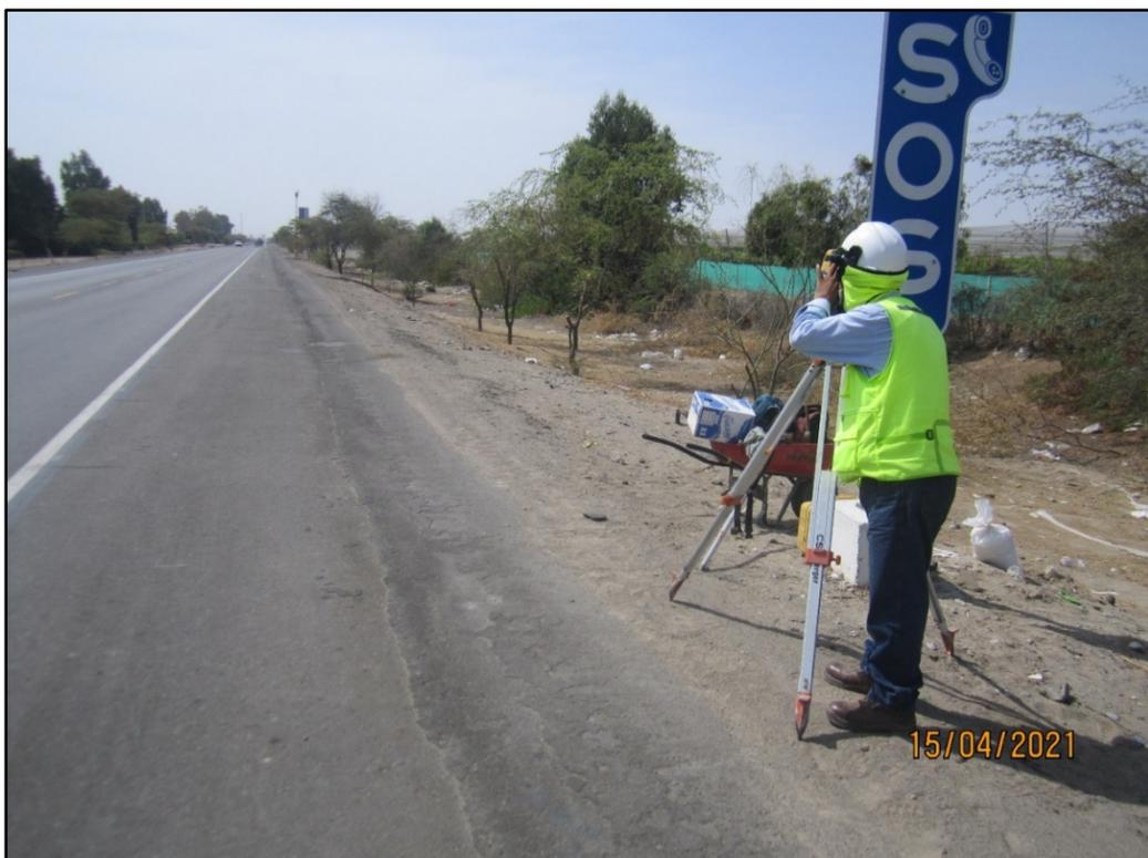
*Figura 12.* Nivelación con la cuadrilla de topografía para la colocación de BMs auxiliares en el km 127+000 al km 128+000.
