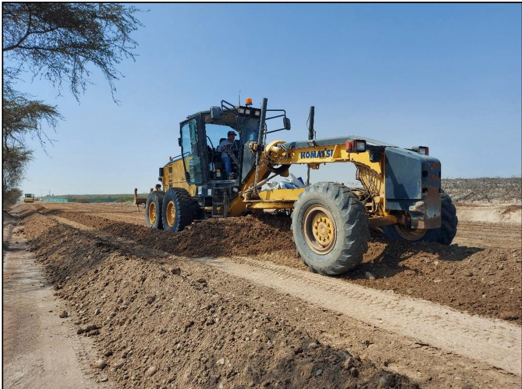
*Figura 25.* Uso de motoniveladora para esparcir material de relleno.
