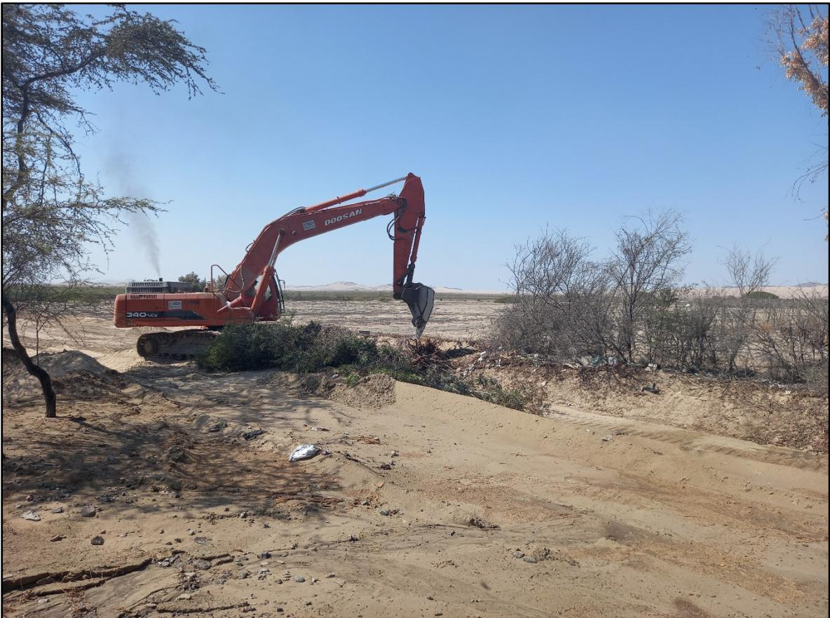
*Figura 13.* Limpieza y desbroce del terreno, utilización de pala mecánica para fines de remoción de vegetación con tallo profundo.
