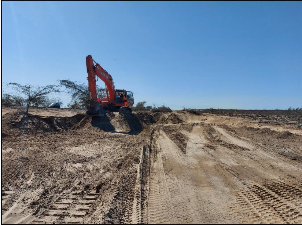
*Figura 22.* Excavación de material con excavadora sobre oruga hasta llegar a los niveles establecidas en los planos.
