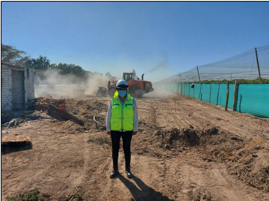
*Figura 21.* Desbroce y limpieza del terreno, utilización de cargador frontal para limpieza del área de trabajo.
