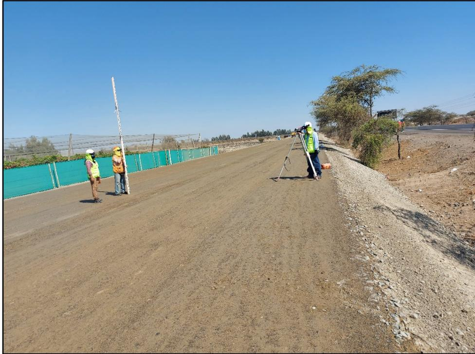
*Figura 28.* Verificación de los niveles de la base con nivel de ingenieros.
