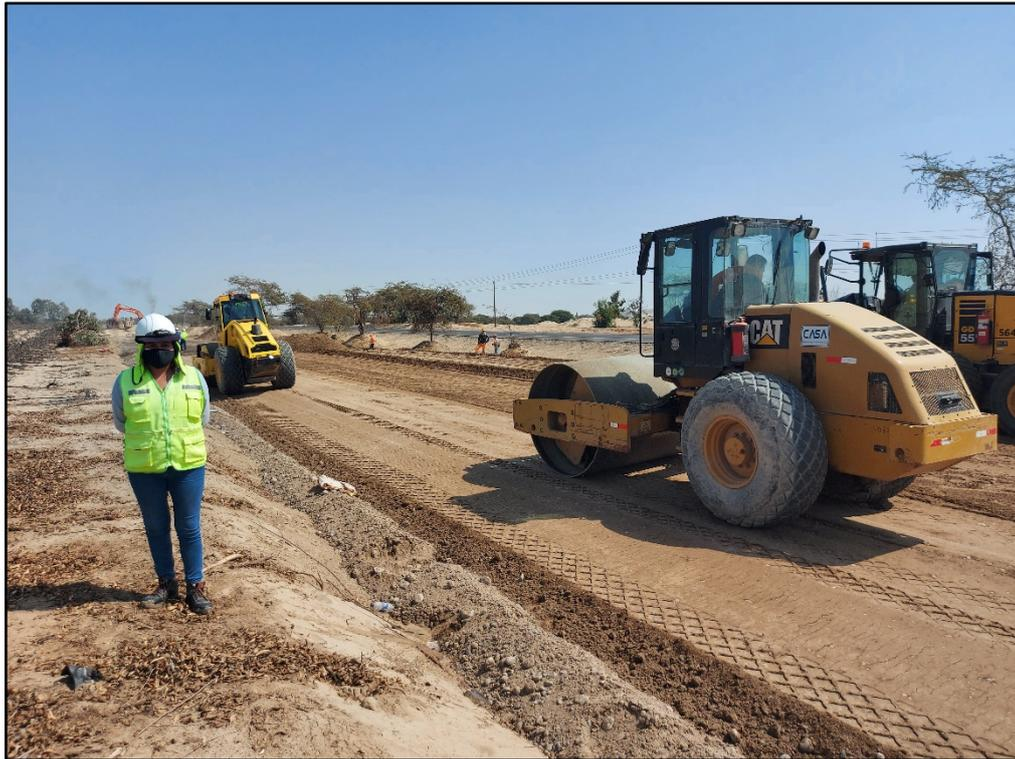
Figura 16. Compactado del relleno utilizando equipos como el rodillo liso vibratorio.
