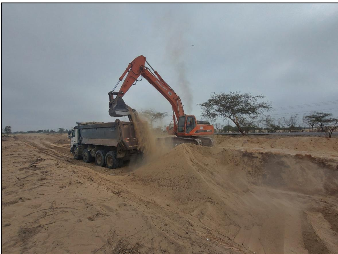
*Figura 14.* Carguío y eliminación de material con el uso de volquete y de pala mecánica hasta llegar a los niveles establecidas en los planos.
