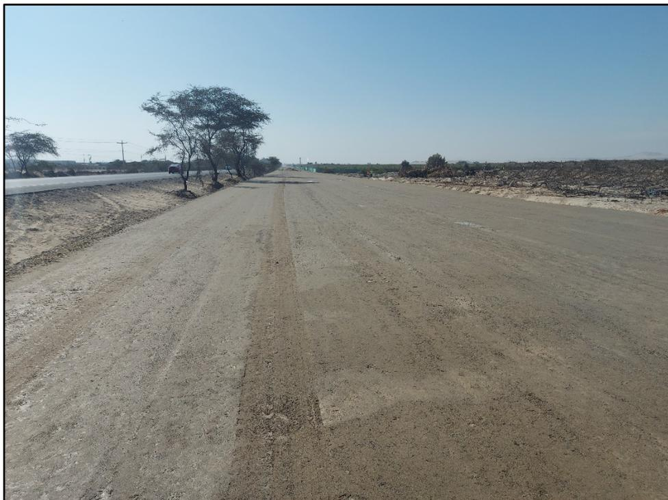
*Figura 29.* Vista del material de base granular humedecida y compactada.
