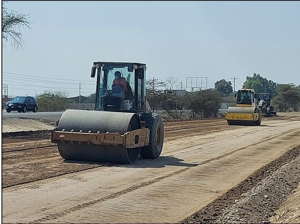
*Figura 26.* Compactación del material de sub-base con 2 rodillos liso vibratorio.
