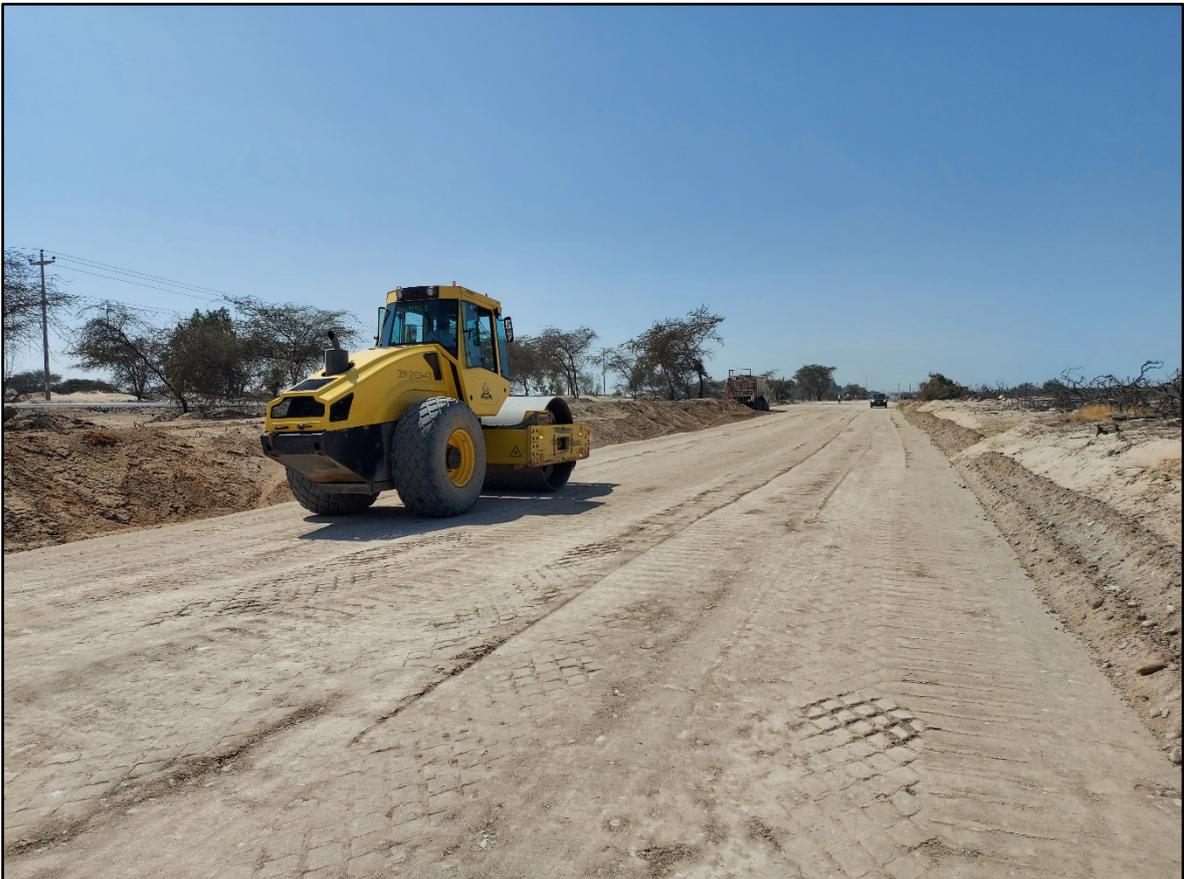
*Figura 17. Compactado del material de la sub-base con rodillo liso vibratorio.*
