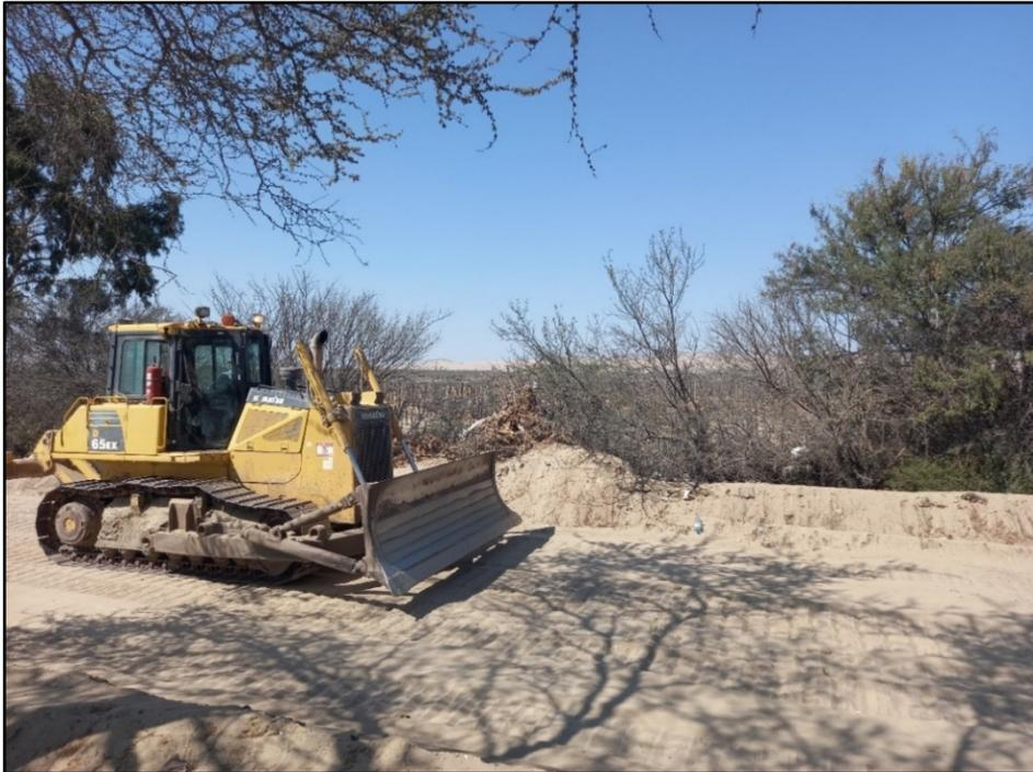
*Figura 20.* Desbroce y limpieza del terreno, utilización de tractor sobre oruga para empujes de material removido de la figura anterior.
