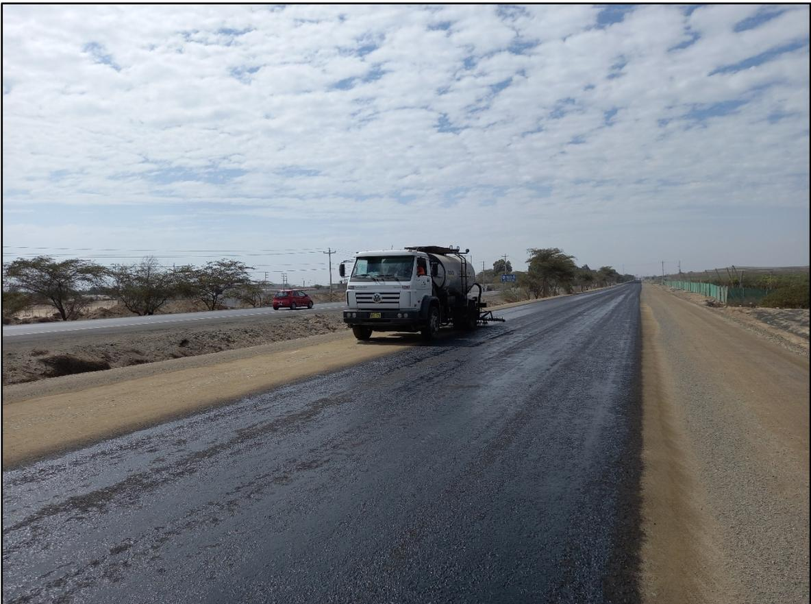
*Figura 18.* Verificación de la unidad mecánica se ha empleado para el riego del material bituminoso
