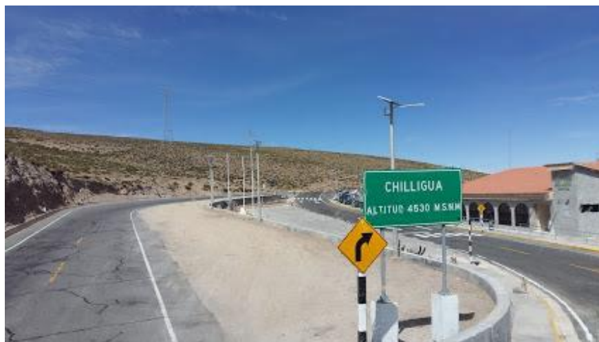
Figura 2. Trafico constante en deterioro de carpeta asfáltica.
