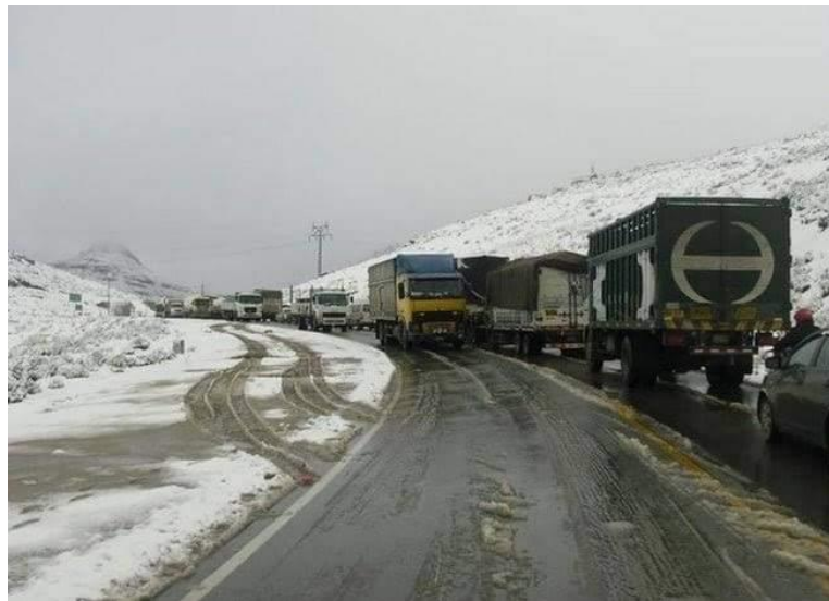
Figura 3. Carpetas asfálticas expuestas a climas fríos.
