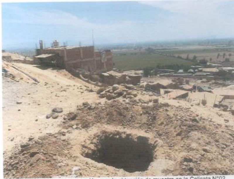
Se realiza la excavación para la obtención de muestra en la Calicata N°02
