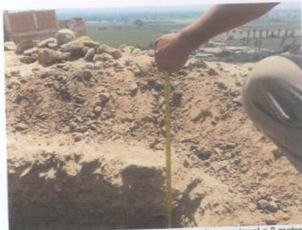
Se toma la profundidad de excavación, cuya altura es igual a 3 metros
