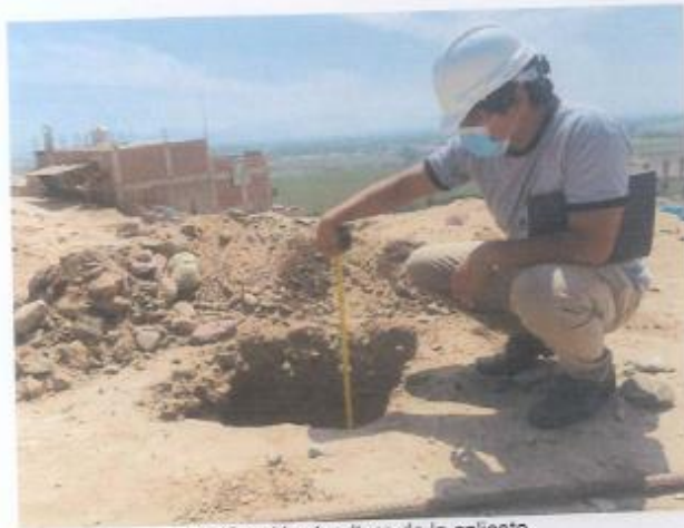
Verificación de altura de la calicata
