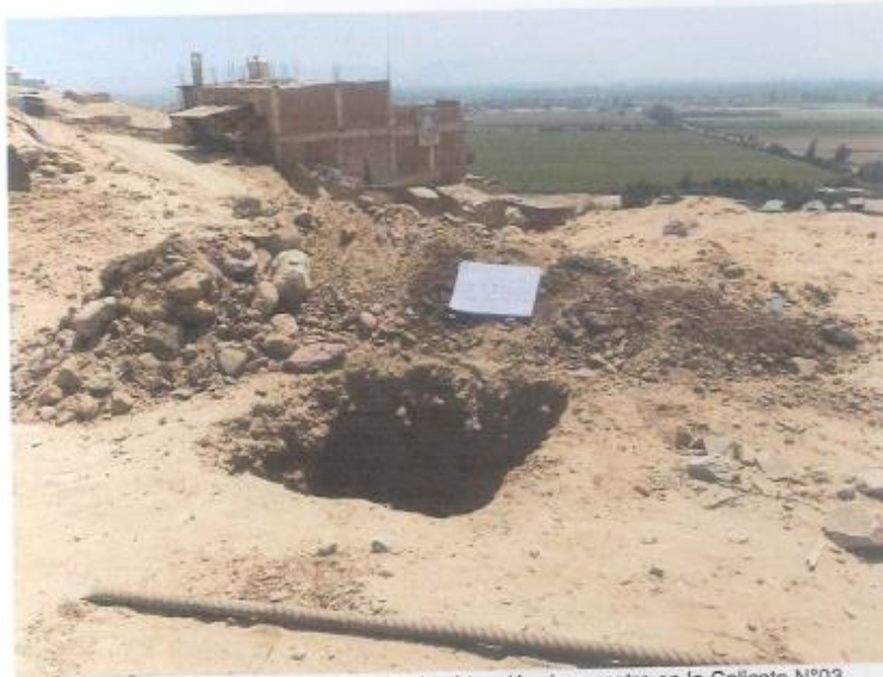
Se realiza la excavación para la obtención de muestra en la Calicata N°03
