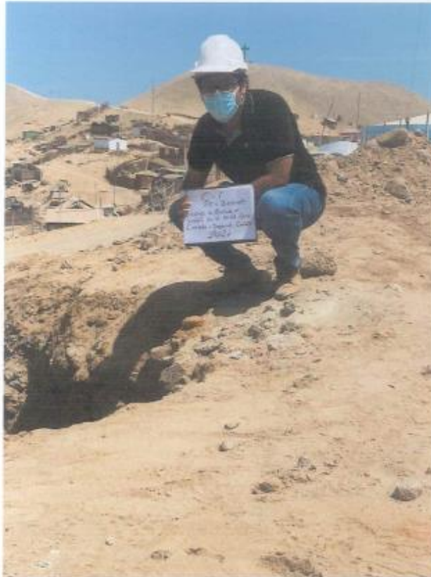
Se realiza la excavación para la obtención de muestra en la Calicata N°01
