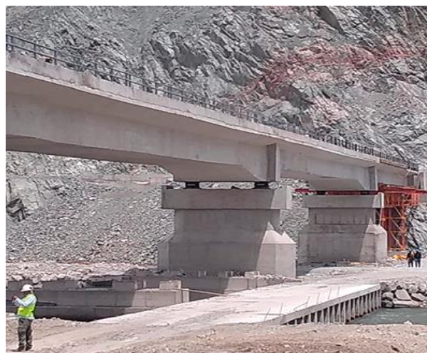
Figura 8. Sistemas de aislamiento dinámico aplicado en el puente Urasqui en Arequipa.
