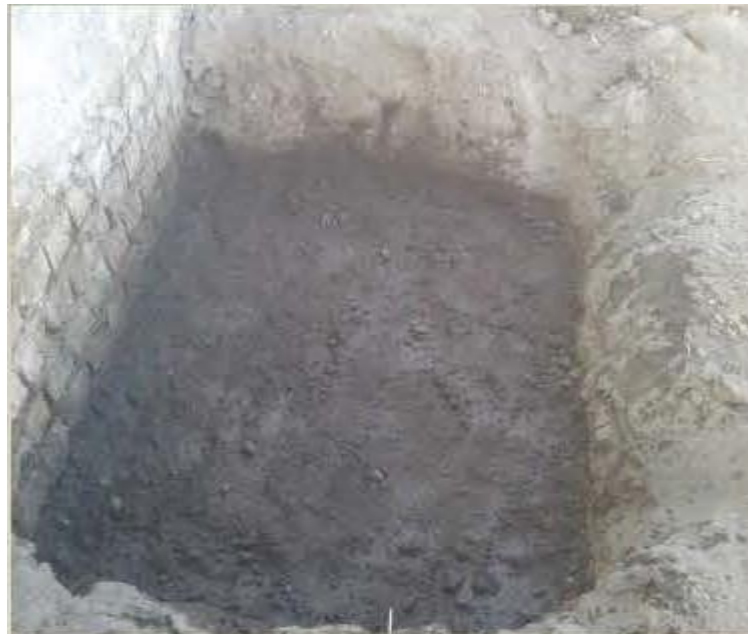
Figura 17. Excavación de Cepa
