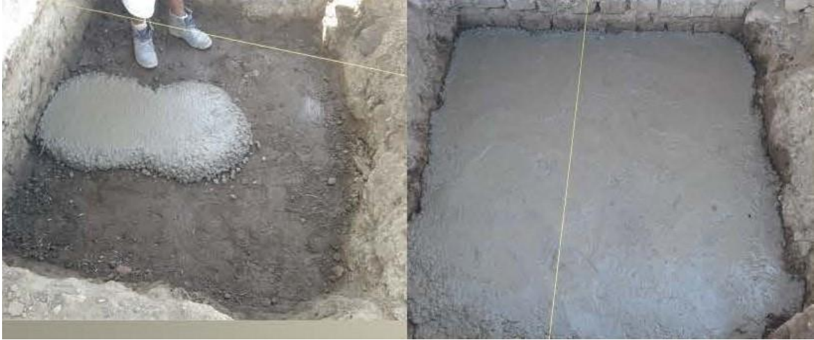
Figura 18. Vaciado de Solado
