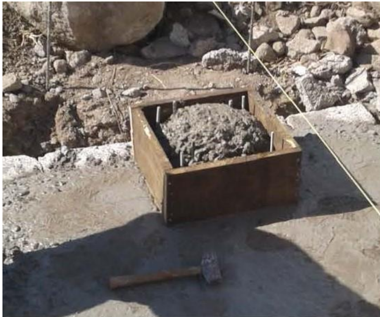
Figura 19. Vaciado de concreto f'c= 350 \text{ kg/cm}^2 .
