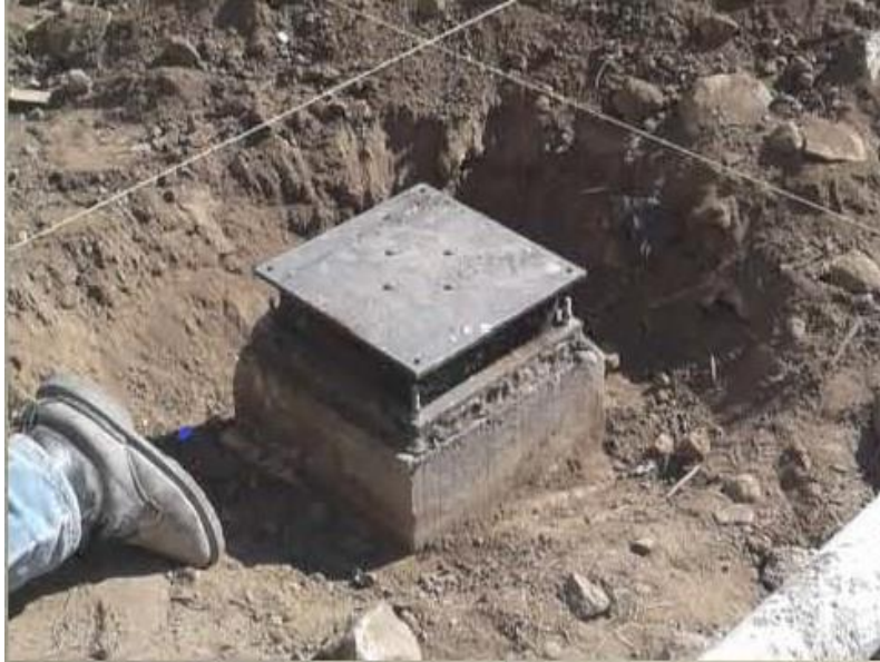
Figura 20. Instalación de aislador de péndulo friccionante.
