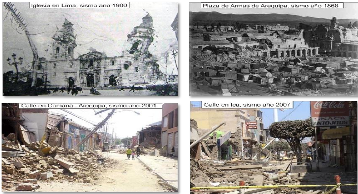
Figura 2. Daños producidos por sismos.
