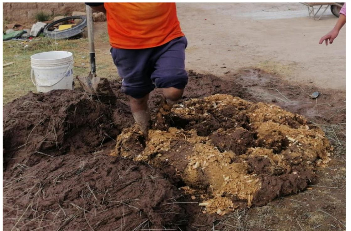
**FOTO N°6: Adición de fibra de las fibras de eucalipto a l mezcla**
