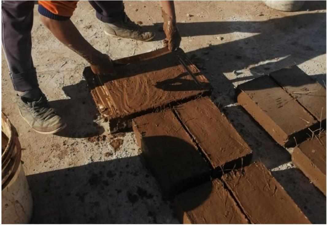
**FOTO N° 9: Enrazado de la mezcla en el molde**
