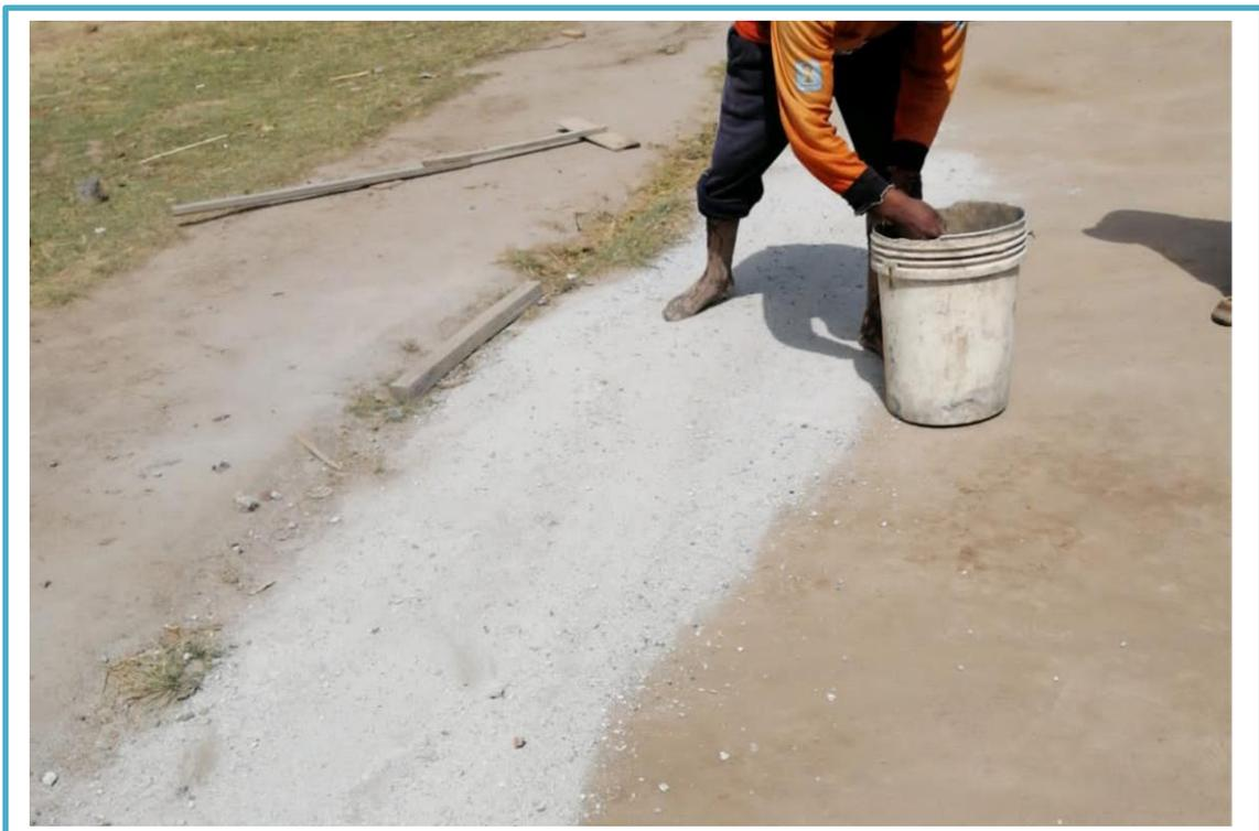
**FOTO N° 12:Proceso de vertido de ceniza a la plataforma de secado y moldeo**
