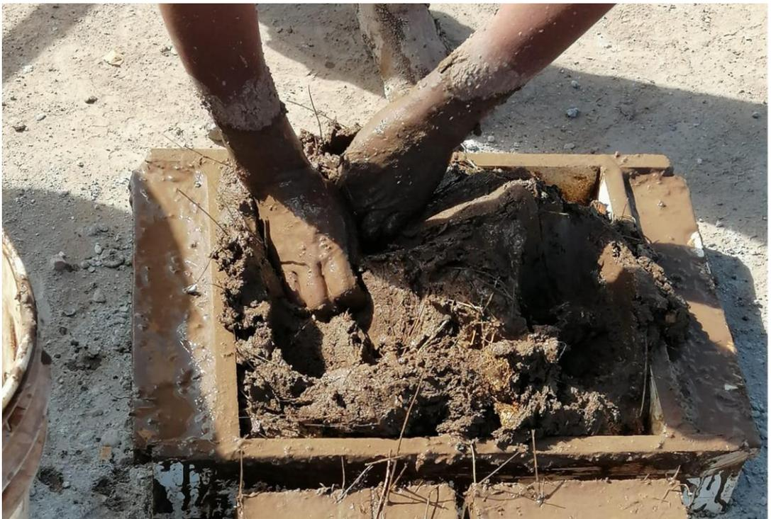
**FOTO N° 8: Vertido y moldeado de la mezcla**
