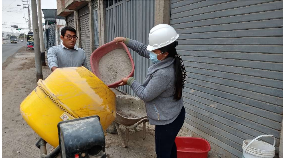
Fotografía N°21: Mezclado de agregados
