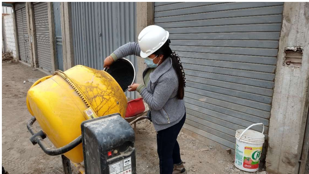
Fotografía N°22: Incorporación del caucho granulado a la mezcla de concreto
