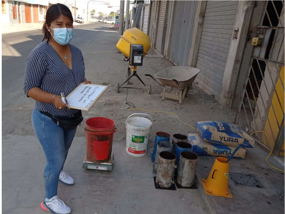
Fotografía N°19: Previo a la elaboración de las probetas de concreto De f'_c = 175 \text{ kg/cm}^2 con adición 0% de caucho reciclado (Patrón) y 15% de caucho reciclado
