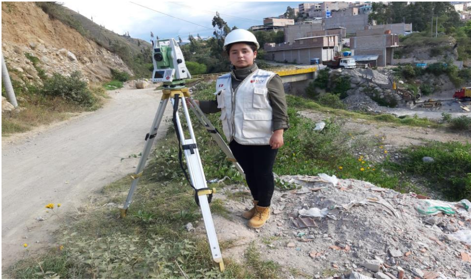
Foto N°5. Punto final de la topografía
