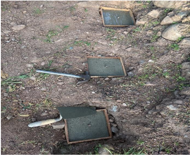
Figura 2: Elaboración de los hitos de control, trabajos en campo mediante estación total Leica Ts 06 plus
