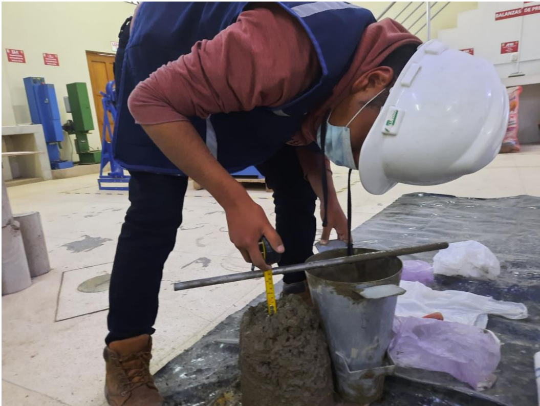
Fotografía 28. Medición del revenimiento del concreto
