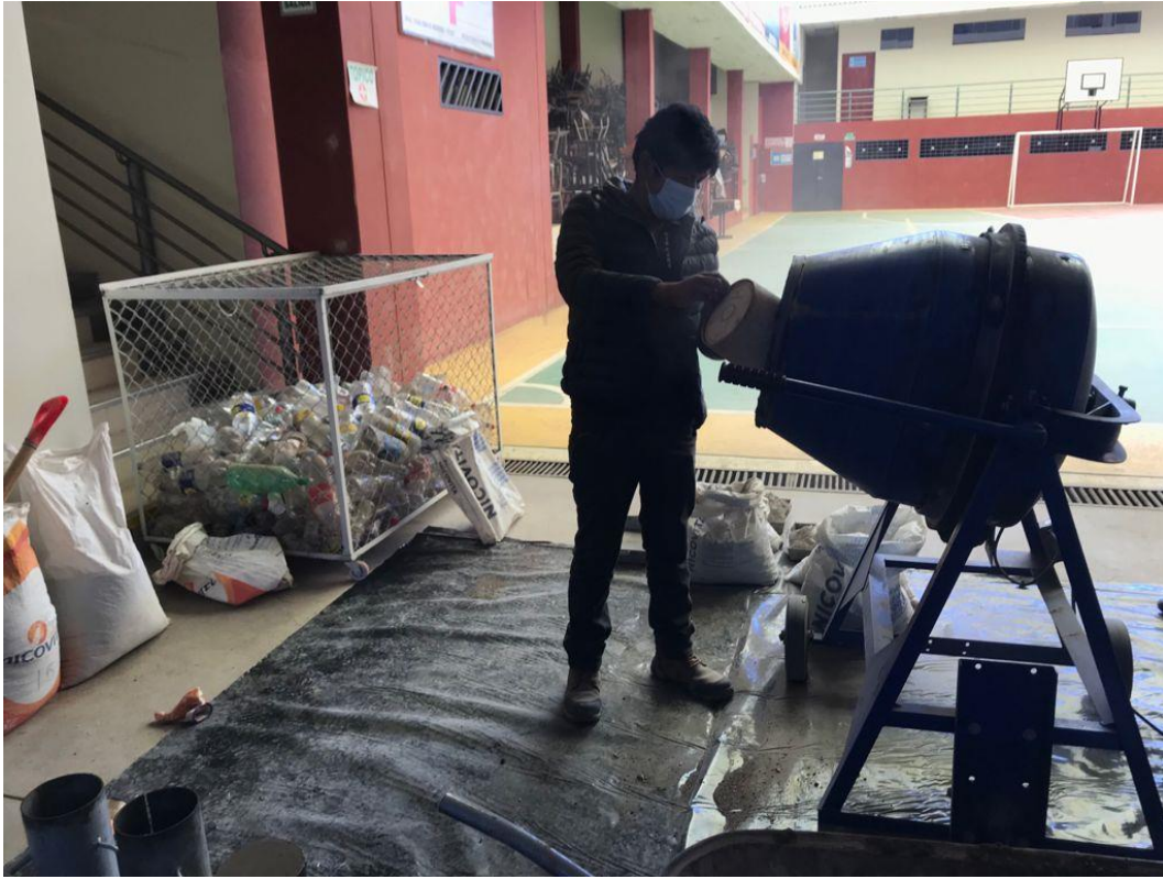
Fotografía 31. Mezclado de materiales con equipo mecánico
