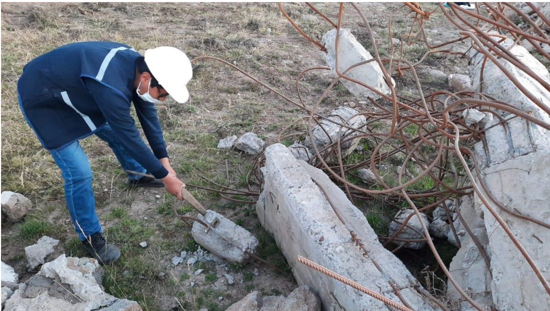
Fotografía 4. Selección y trituración primaria de elementos estructurales
