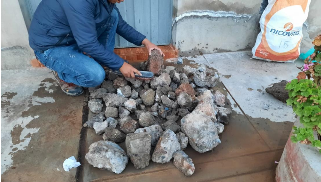
Fotografía 5. Lavado y limpieza de bloques de concreto.
