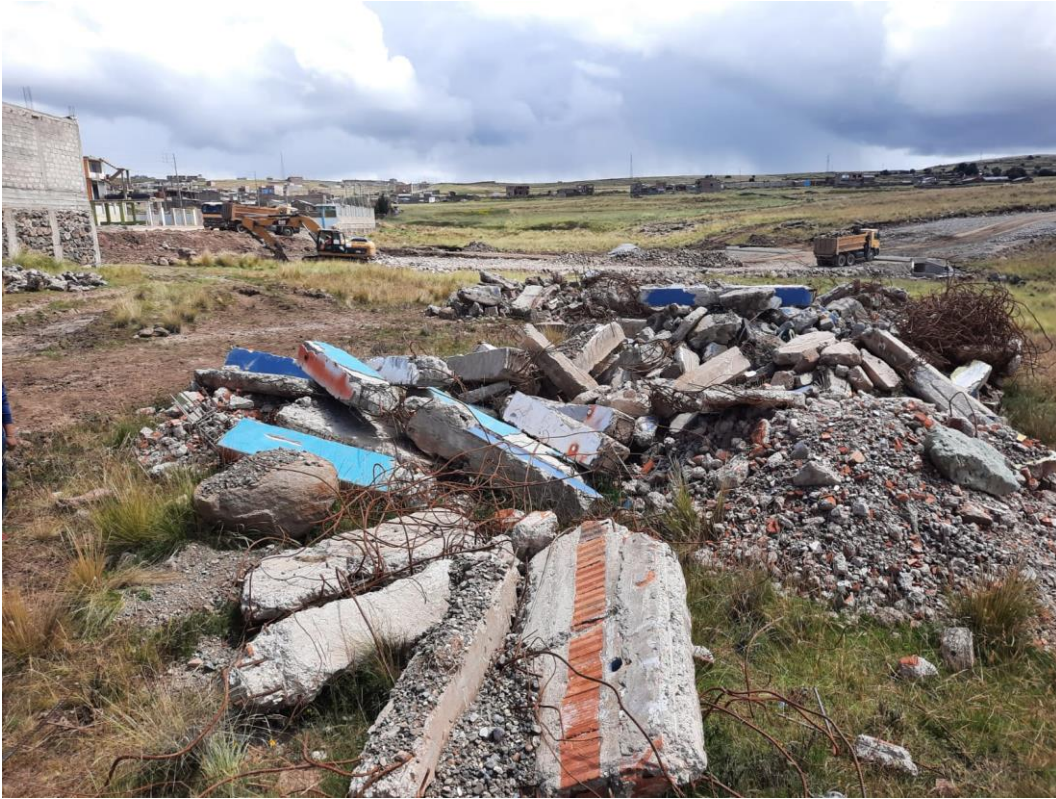
Fotografía 3. Residuos de construcción y demolición.
