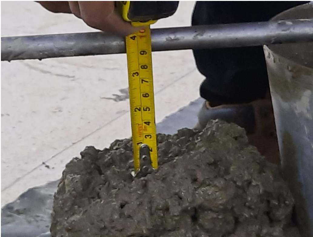
Fotografía 29. SLUMP del concreto, dentro de los rangos de 3" a 4".
