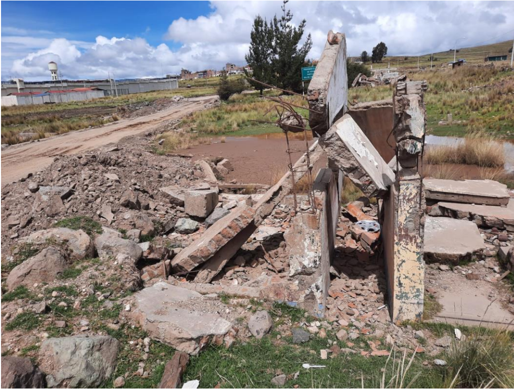
Fotografía 1. Material para muestra (demoliciones de viviendas)
