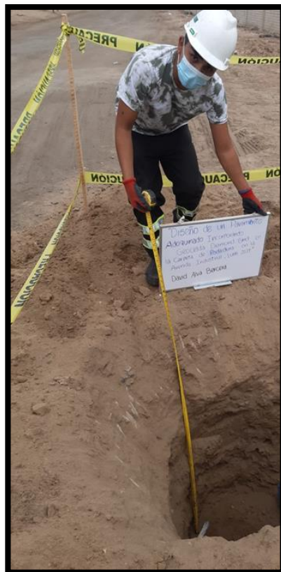
Figura 60. Elaboración de calicatas.
