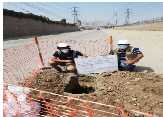
Figura 14: Realizando la calicata C-2
