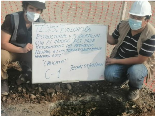
Figura 11: Realizando la calicata C-1
