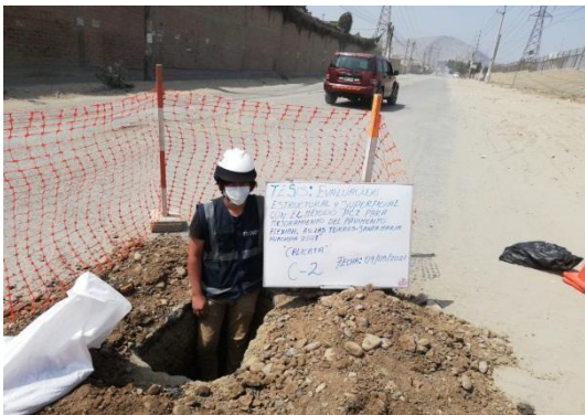
Figura 13: Realizando la calicata C-2
