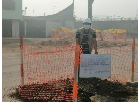
Figura 12: Realizando la calicata C-1
