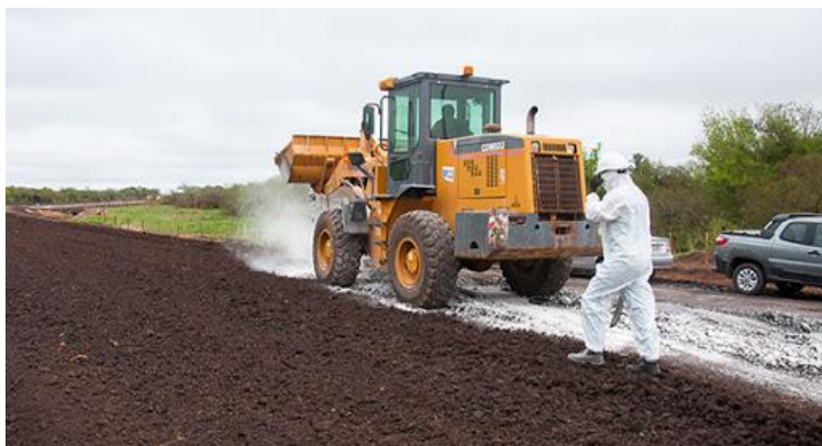
Figura 16. Suelo estabilizado con cal.
