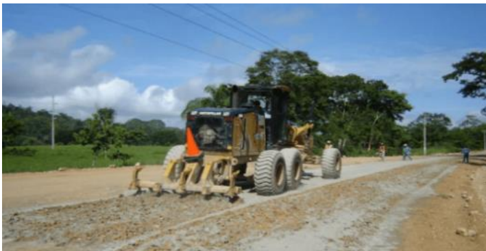
Figura 17. Suelo estabilizado con cemento
