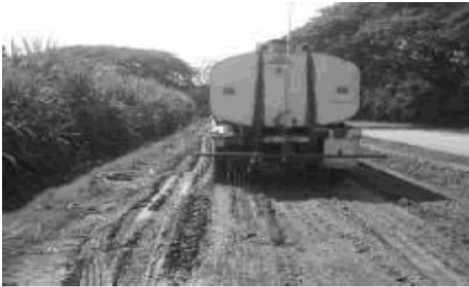
Figura 20. Suelo estabilizado con cloruro de calcio
