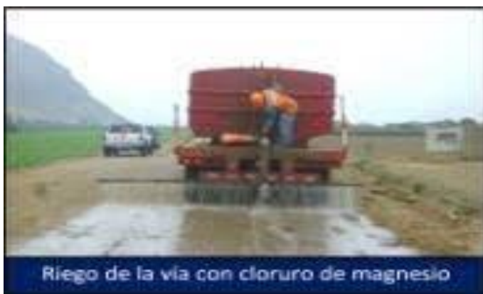
Figura 21. Suelo estabilizado con cloruro de magnesio.
