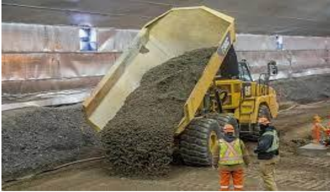
Figura 18. Suelo estabilizado con Escoria.
