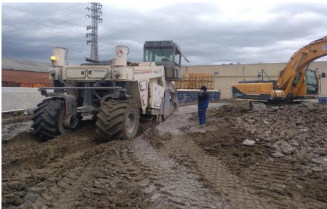
Figura 15. Estabilización mecánica de suelos
