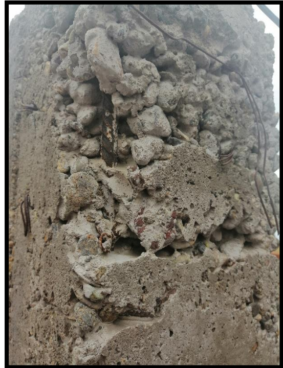
Fotografía 11 y 12: Tomando medidas para determinar áreas con cangrejas en viga y columna.
