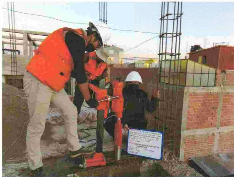
FOTO N°6: EXTRACCIÓN VERTICAL DE NÚCLEO DE VIGA ESTRUCTURAL
