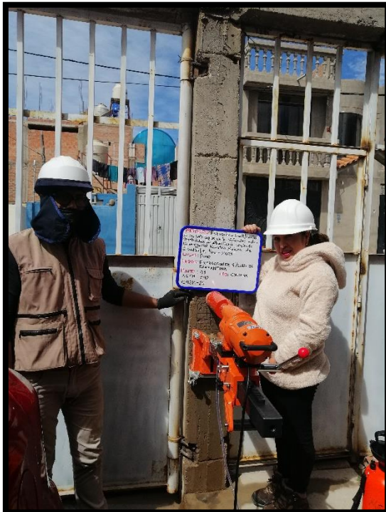
Fotografía 21 y 22: Realizando el ensayo de extracción de núcleos diamantinos en elementos estructurales en columna.
