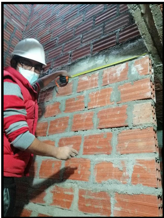
Fotografía 7 y 8: Tomando medidas para determinar áreas con eflorescencia en vigas y muros.
