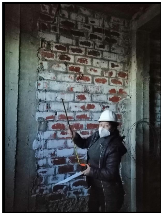
Fotografía 7 y 8: Tomando medidas para determinar áreas con eflorescencia en vigas y muros.
