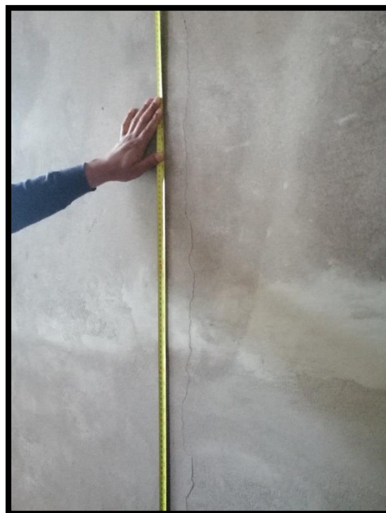
Fotografía 9 y 10: Tomando medidas para determinar áreas con fisuras en muros.
