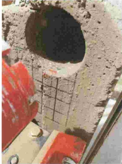
FOTO N°1: EXTRACCIÓN DE UNA DE LAS MUESTRAS DE NÚCLEO DE CONCRETO
