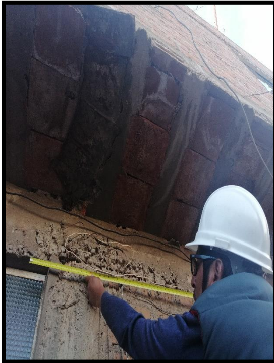
Fotografía 11 y 12: Tomando medidas para determinar áreas con cangrejas en viga y columna.
