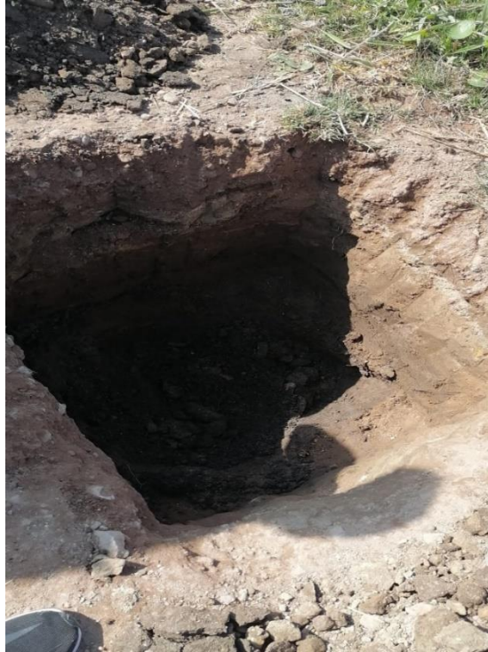
Figura 43. Excavación de la calicata 1m de ancho por 1m de largo
