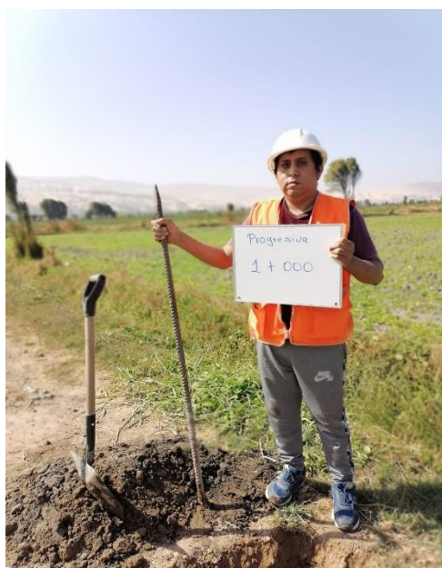
Figura 42. Ubicación de la calicata progresiva km. 1+000
