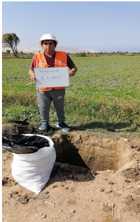
Figura 43. Excavación de la calicata 1m de ancho por 1m de largo
