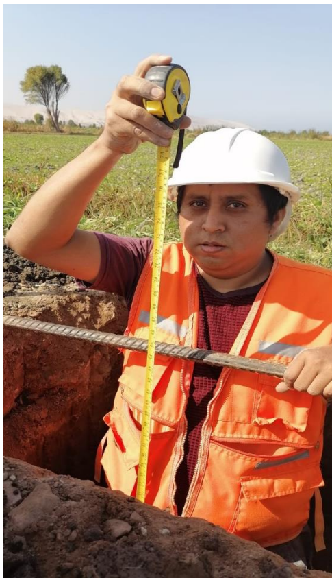
Figura 41. Medición de la calicata 1.50m. de profundidad.
