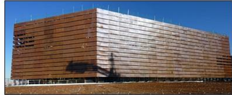
Ilustración N° 19: Exterior del Auditorio. Volumen fuerte y agresivo.
