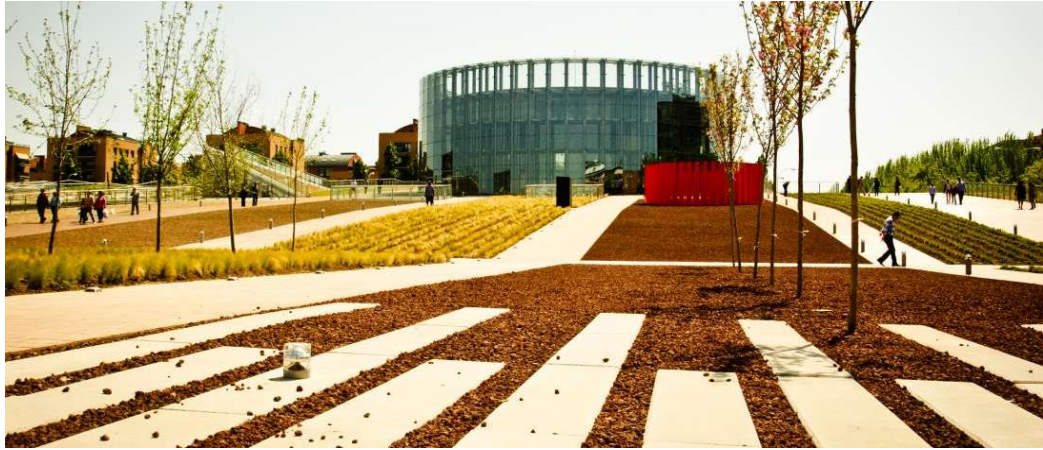
Ilustración N° 117: Cubiertas Transitables del CREEA.
