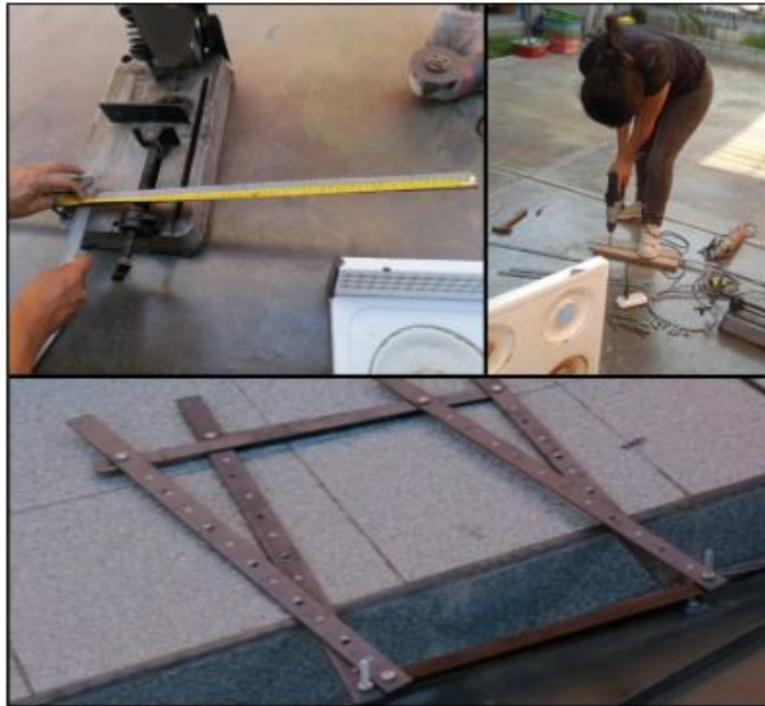
Figura 20. Procedimiento de la perforación de la platina
