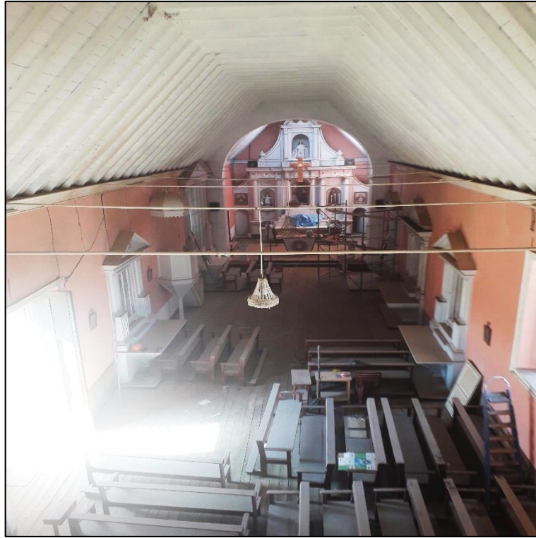
Fotografía 2. Vista interior de la iglesia de Pachía
