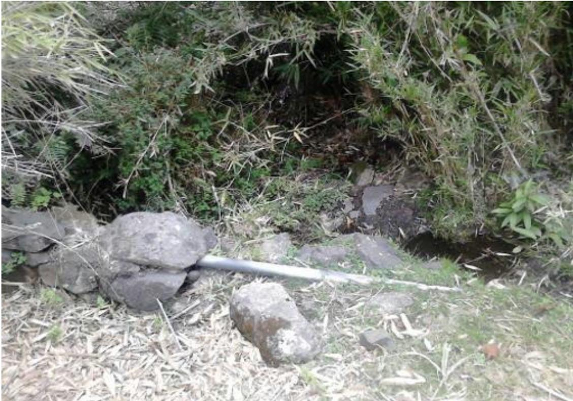
**Foto N°05:** Tuberías expuestas a menos de 0.30 m de la línea de conducción.
