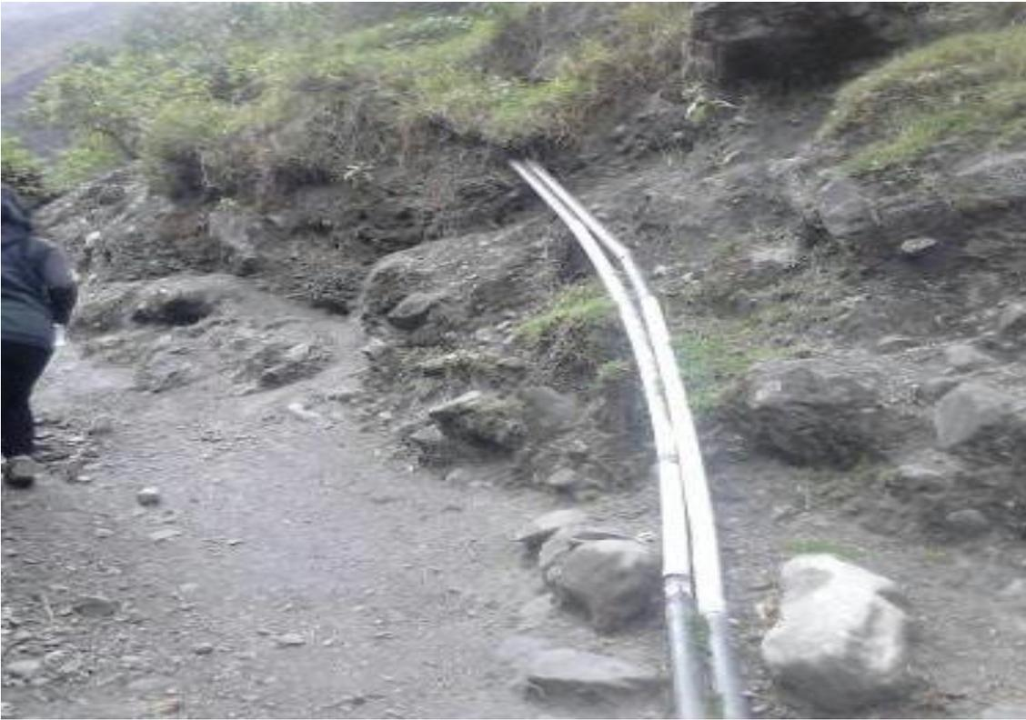
**Foto N°03:** Tuberías expuestas de la línea de conducción.
