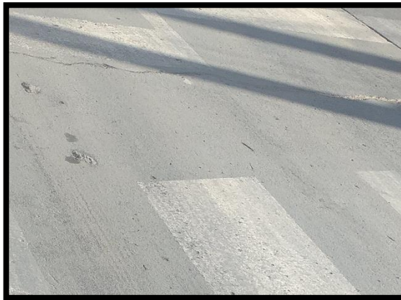
Figura 12. Grietas Lineales
