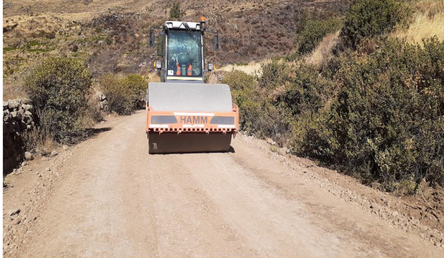
Figura 13. Compactación de una base con el rodillo.
