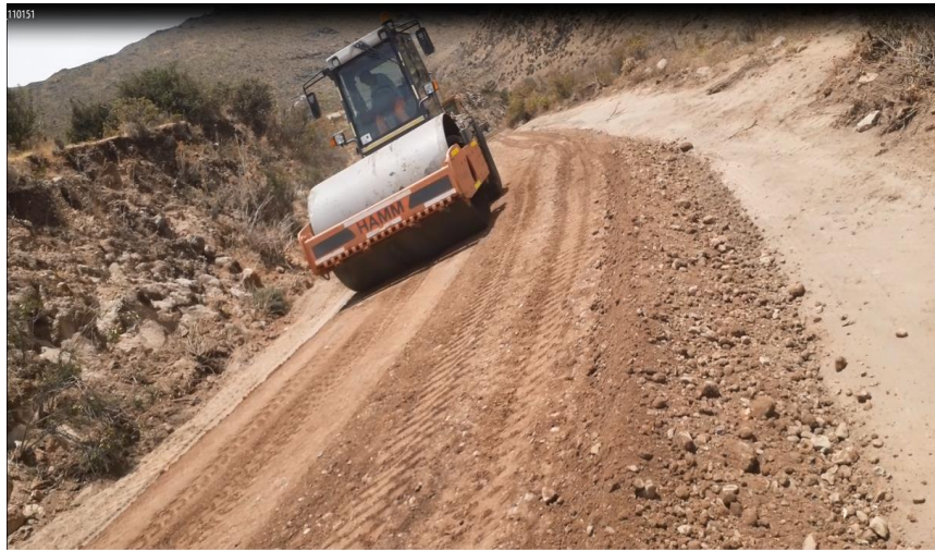
Figura 12. Compactación de la base.
