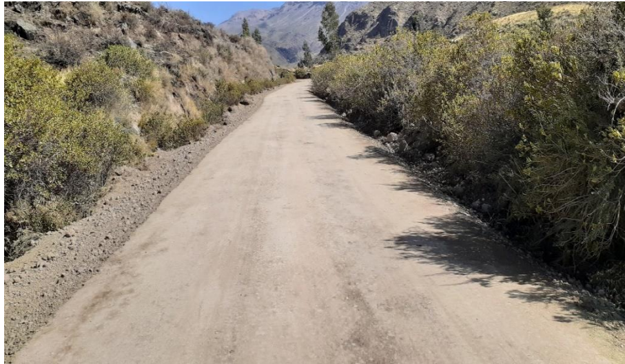
Figura 3. Base de una carretera ya conformada
