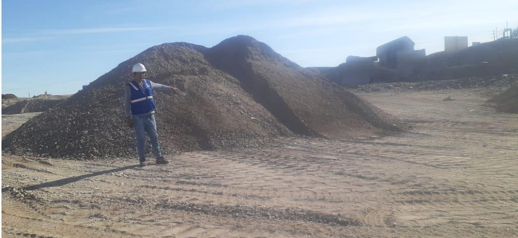
Figura 6. Suelo granular para base.
