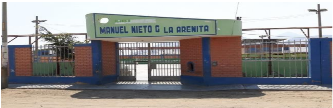
Figura 27. Equipamiento existente en el Sector La Arenita - Complejo Deportivo Manuel Nieto G.
