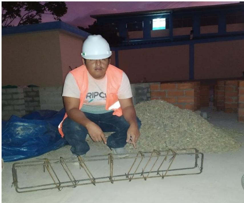
Figura 47: Armadura de viga tipo II (con estribos de 62.5°)
