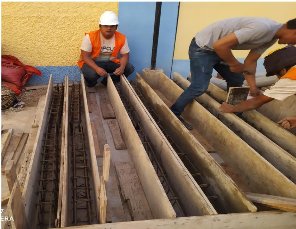
Figura 49: Encofrado con tablas contraplacados de Triplay y barrote de vigas
