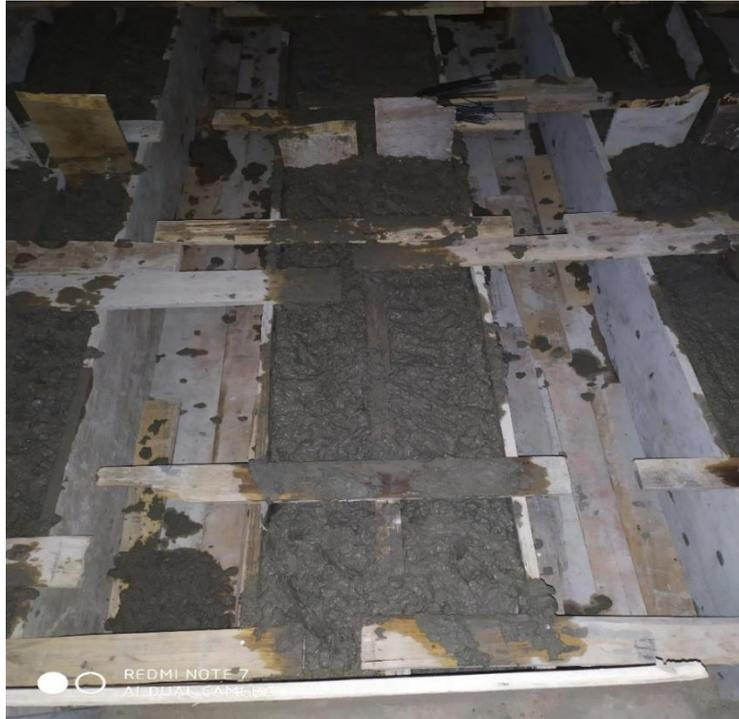
Figura 50: Vaciado de concreto con resistencia a la compresión  $f'_c=210\text{kg/cm}^2$
