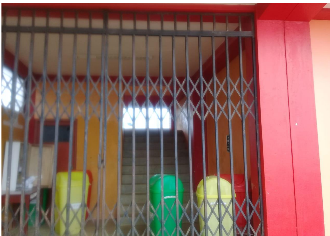
Figura 105: Escalera que conecta los dos niveles del módulo I de la IE. 10410
