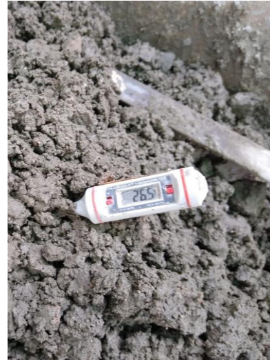
Medición de temperatura en concreto fresco.
