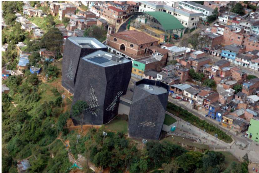
Figura 1. Vista aérea del Parque Biblioteca España
