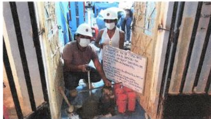
FOTOGRAFIA 24: Muestra la Consistencia Mediante la Prueba de Slump de la Mezcla de Concreto con Adición al 3% del Proyecto de Tesis: "Influencia de la cáscara de arroz en el Diseño de Concreto de f'c=210 kg/cm 2 Para Reducir Peso en Losas Aligeradas, Jaén – 2021"
