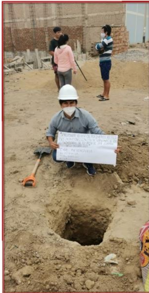
Fotografía N° 08. localización de la calicata C-02 en la Av. Venezuela
