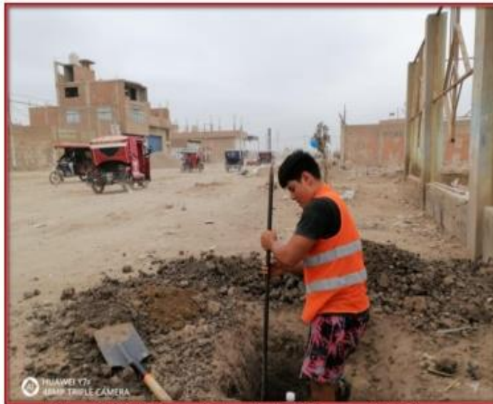
Fotografía N° 01: Excavación de calicata C-01 en avenida la Despensa
