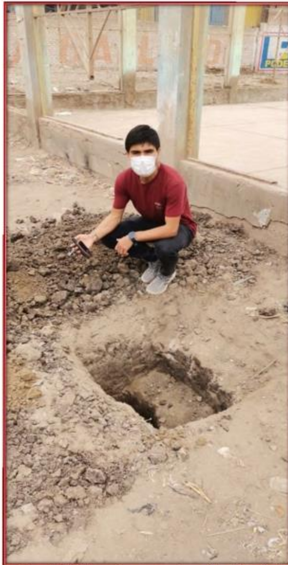
Fotografía N° 05: toma de punto georreferenciado de la calicata C-01 con GPS navegador
