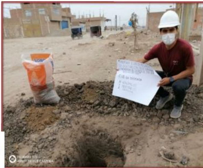
Fotografía N° 02: Extracción de muestra alterada de calicata C-01 en avenida la Despensa
