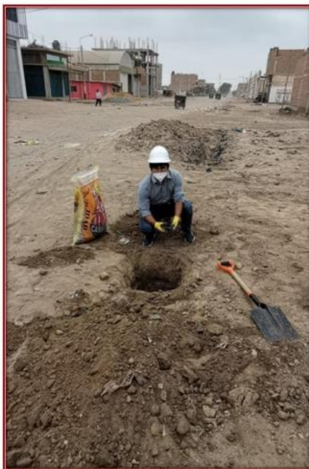
Fotografía N° 06: toma de punto georreferenciado de la calicata C-02 con GPS navegador en Av. Venezuela
