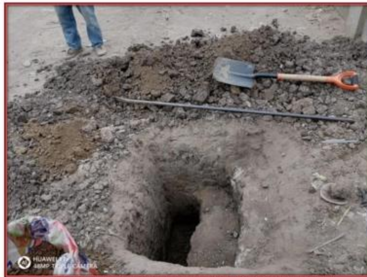
Fotografía N° 03: Perfil de suelo calicata C-01 profundidad 1.50m
