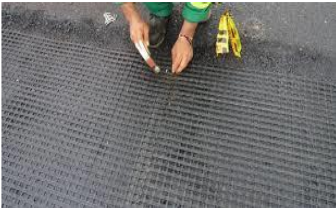
Figura 5: Instalación de la geomalla
