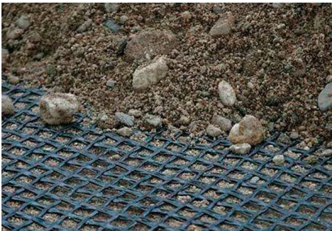
Figura 6: Aplicación de las mallas de refuerzo
