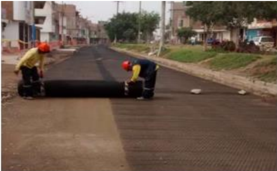
Figura 3: Instalación de la geomalla
