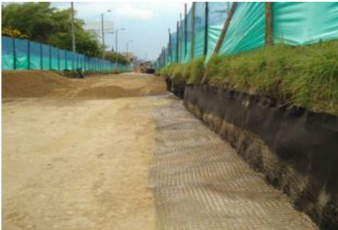
Figura 4: Instalación de la geomalla
