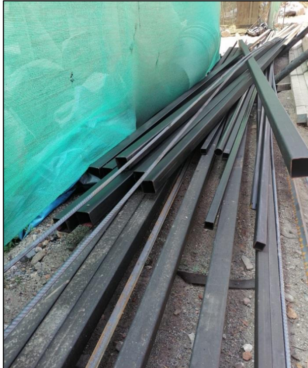
Almacén de material 2
