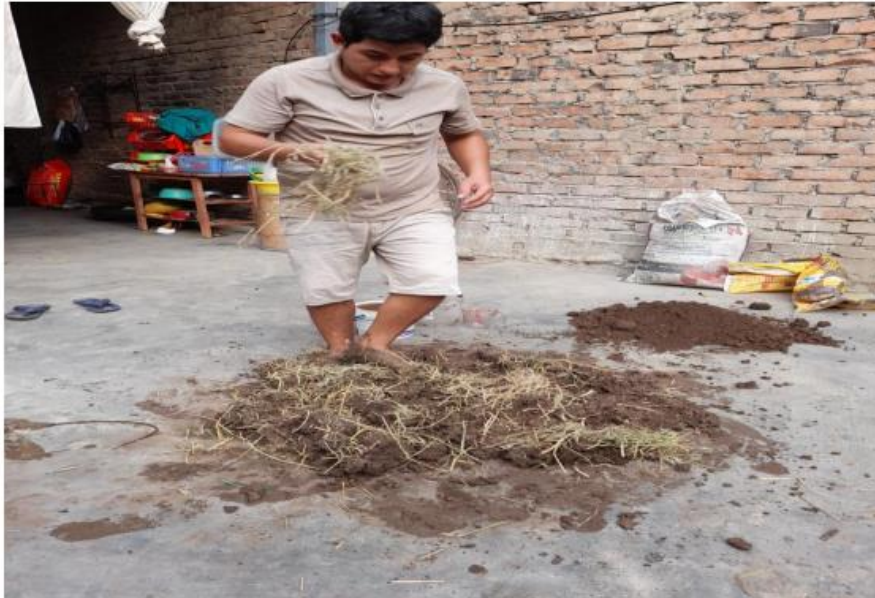
FOTOGRAFÍA 11: Mezclado de insumos para la elaboración de los adobes.
