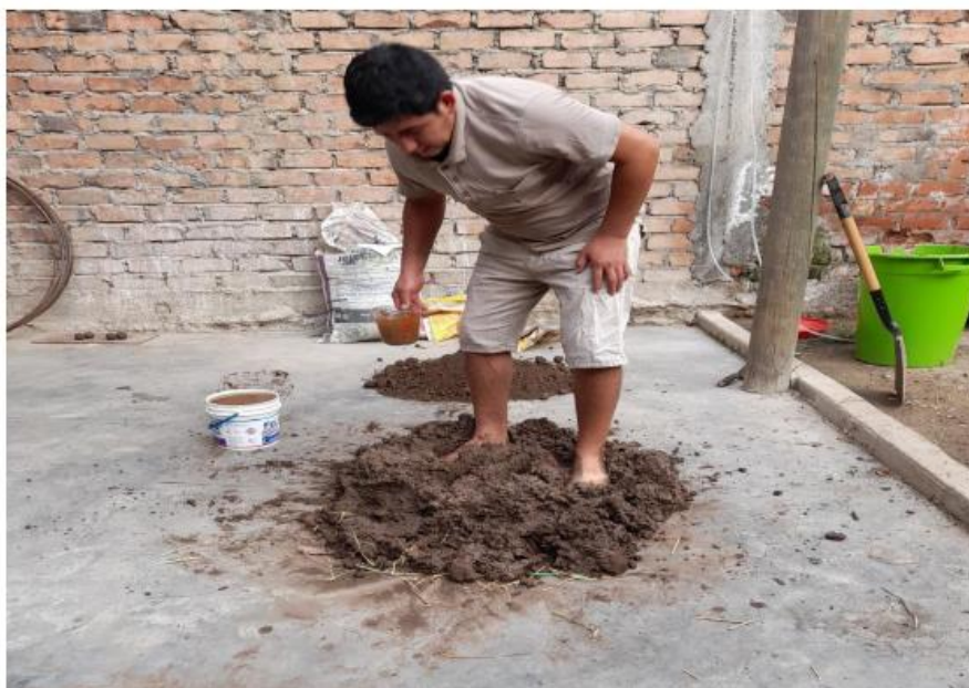
FOTOGRAFÍA 12: Disposición del porcentaje medido de mucílago de café para agregar a la mezcla.
