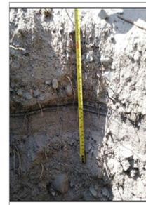
De la carretera Cascajal Izquierdo (progresiva 6+000 - 7+000 km) se encuentra a nivel de subrasante, el cual ha sido sometido a erosión debido al fenómeno del niño del año 2017, el cual generó daño directamente a dicha progresiva.
