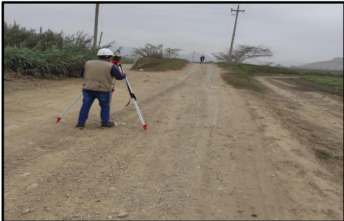
FIGURA Nº12: SE OBSERVA UN PUNTO DE LA VIA CON LA MIRA TOPOGRAFICA EN EL KM 15 CASCAJAL – IZQUIERDO
