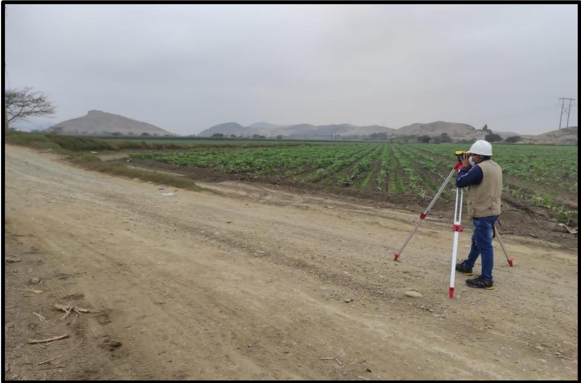
FIGURA N°09: PODEMOS OBSERVAR EL LEVANTAMIENTO TOPOGRAFICO DE LA CARRETERA KM 15 CASCAJAL – IZQUIERDO
