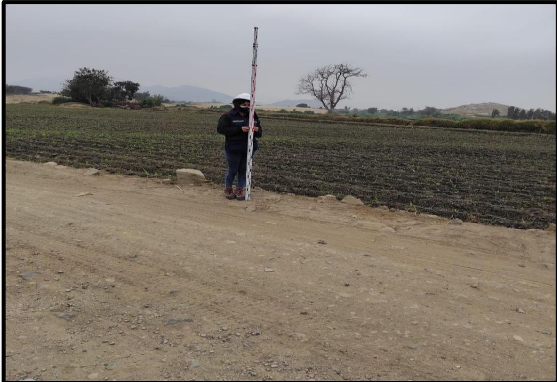
FIGURA Nº12: SE OBSERVA UN PUNTO DE LA VIA CON LA MIRA TOPOGRAFICA EN EL KM 15 CASCAJAL – IZQUIERDO
