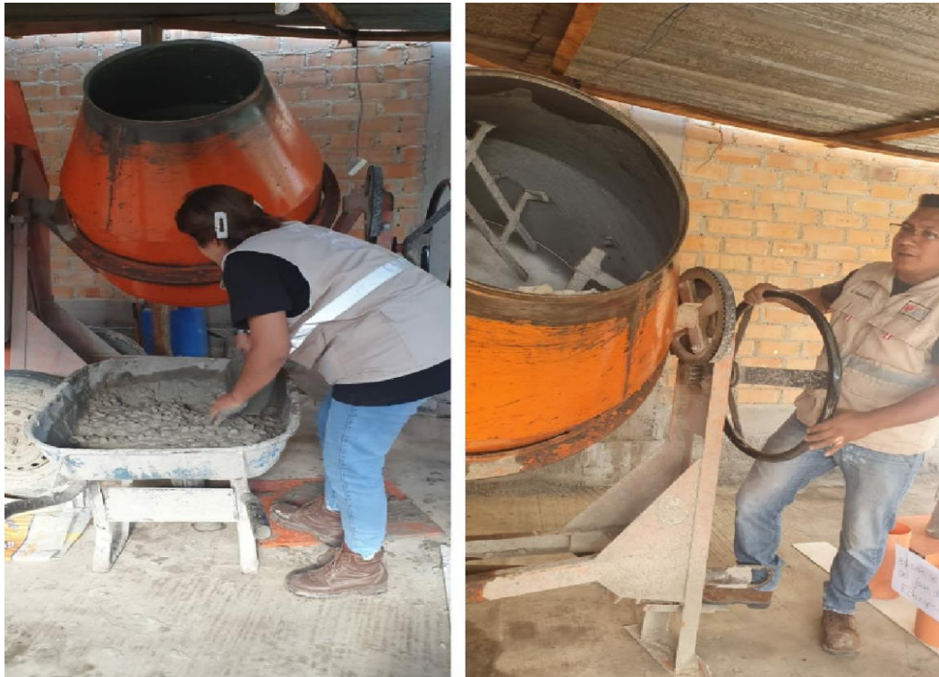
Procedimiento de mezcla de los agregados para concreto 175kg/cm 2
