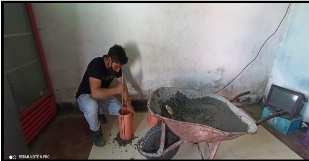
Figura 12. Moldeo de los testigos de concreto
