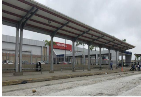
Figura 21.- Fotografía de inicio de obra del terminal terrestre de Machala
