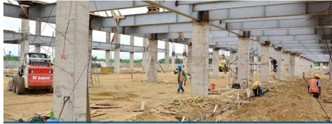
Figura 22.- Fotografía trabajos del terminal terrestre de Machala
