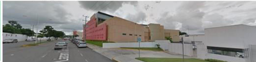
Al Sur colinda con el Centro Estatal de Transfusión de sangre, teniendo 6 pisos de altura, sin comunicación u conexión entre estas.
