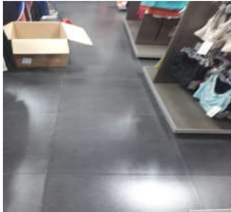
Figura 9: Área de almacén sucia
