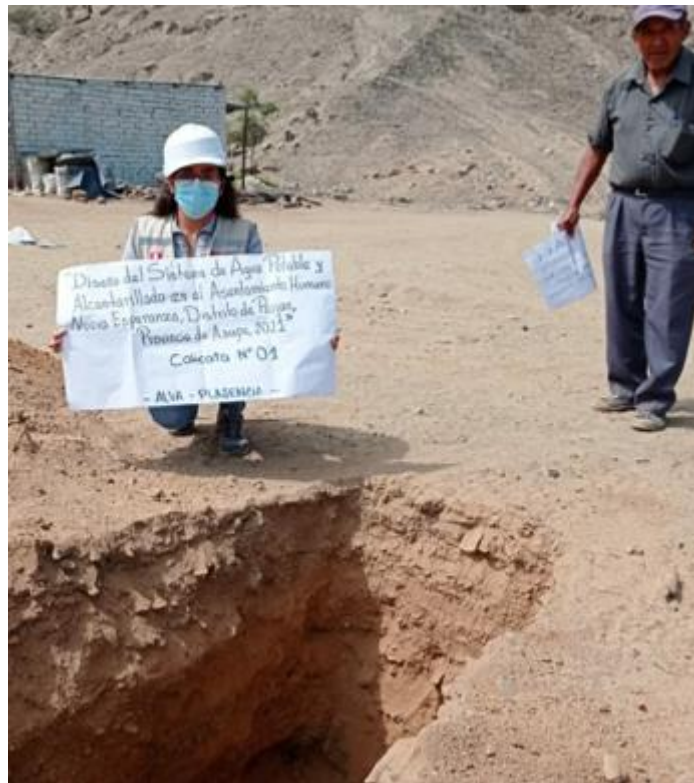
FOTO N°10: Inspeccionando la ejecución de las calitas
