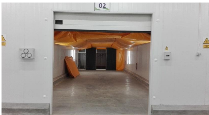
Figura 25. Túnel de enfriamiento modelo californiano de (complejo agroindustrial beta s. A, Piura).
