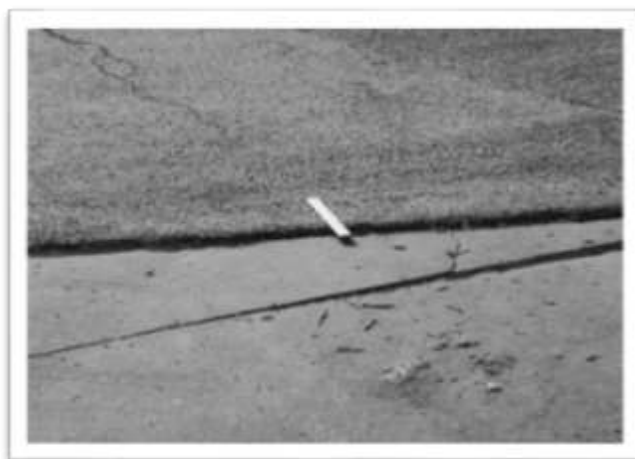
Figura 47: Desplazamiento, severidad media
