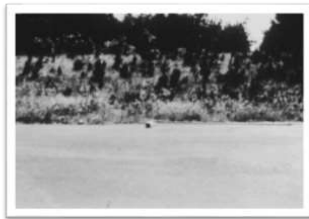
Figura 52: Hinchamiento, el nivel de severidad se basa en criterios de calidad de manejo
