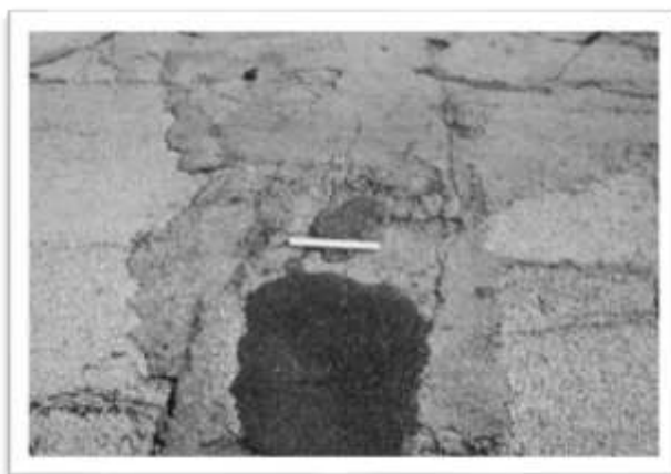
Figura 35: Parchado y acometida de servicio, severidad alta
