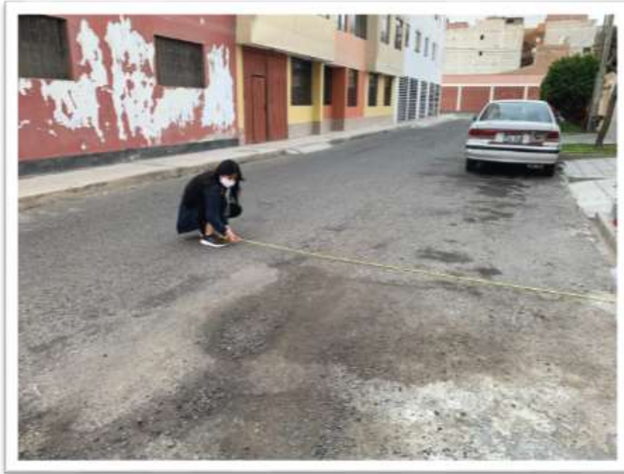
Figura 65: Medición de fallas en campo
