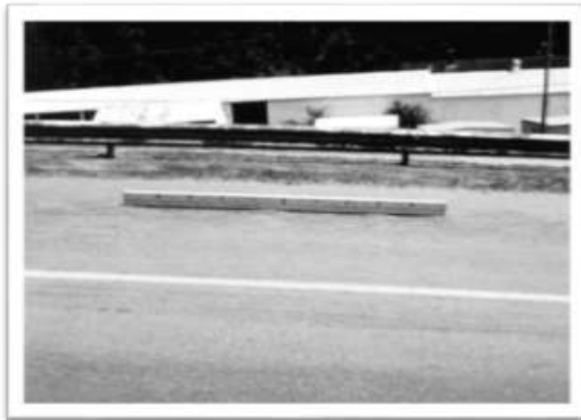
Figura 16: Corrugación, severidad media
