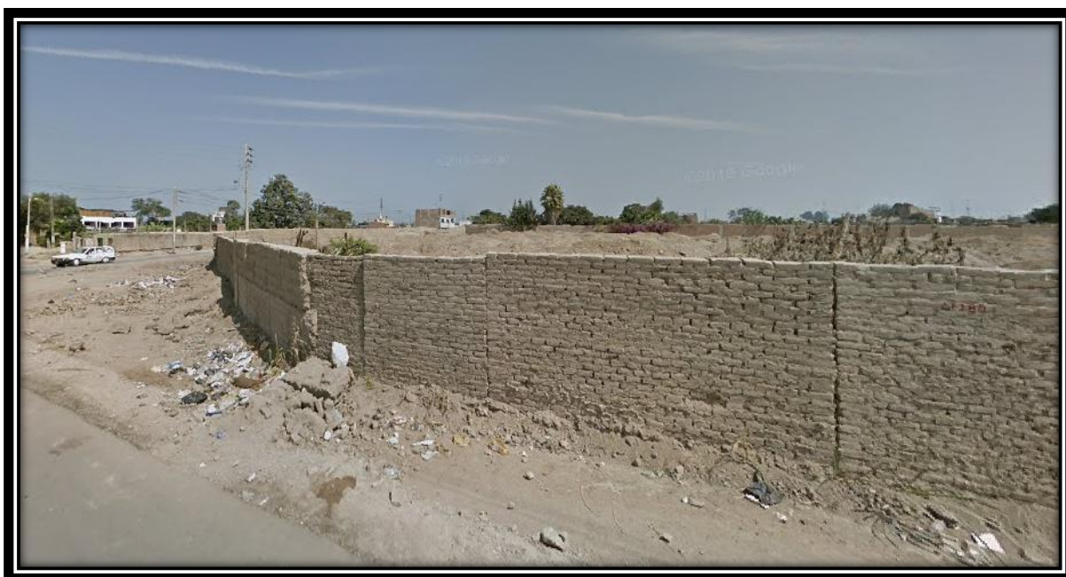
Figura N° 1: Espacios públicos descuidados
