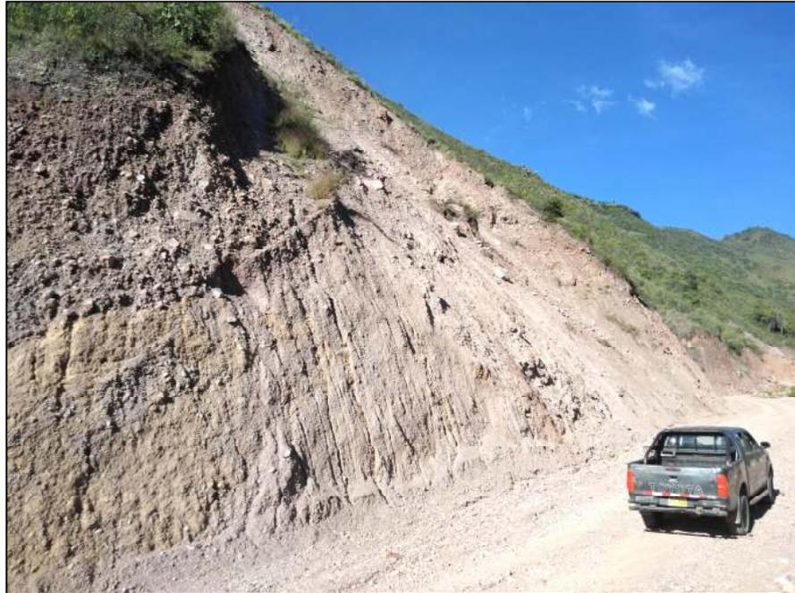
*Figura 51.* Quedando la vía de esta manera donde solo se realizó la limpieza del material deslizado mas no una algún método de estabilización, donde este talud es estable pero no cumple con los factores de seguridad establecido por el RNE CE.020 siendo este una trampa mortal para quienes la transitan por eso ya no se puede esperar tanto a que pase algún accidente.
