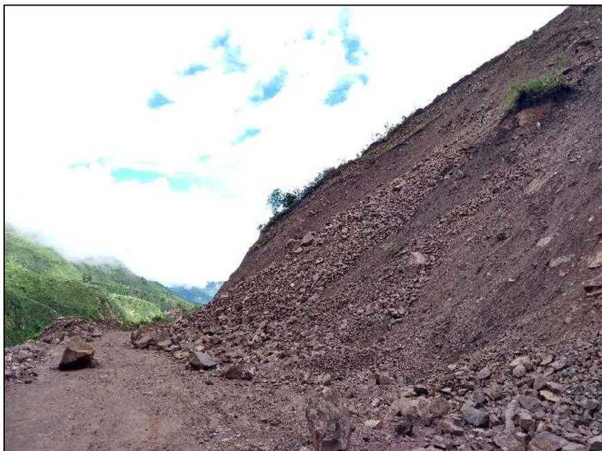
*Figura 49.* En la vía Moyaccasa –Pulcay progresiva 12+100 al 12+180 se observa el deslizamiento del talud pudiendo ocasionar accidentes a los que la transitan.
