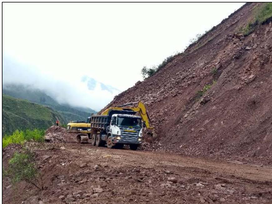
*Figura 50.* Ya que este es una vía de gran importancia, se realizaron las limpiezas de los deslizamientos del talud en la plataforma de rodadura con las maquinarias.
