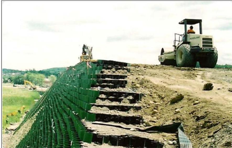
Figura 18. Construcción de muro de gravedad con geoceldas.
