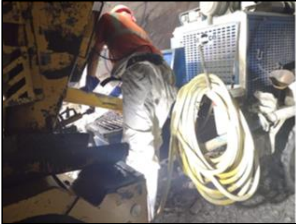
Fotografía 9. Traspaso de shotcrete de equipo mixer a robot alpha
