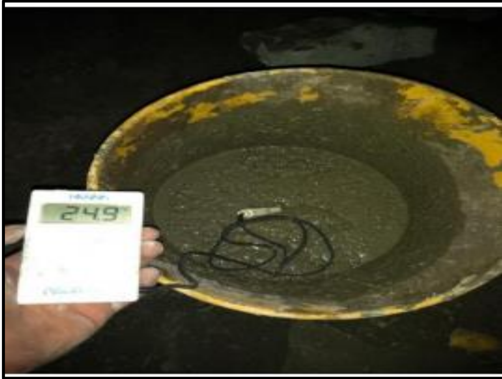
Figura 11. Medición de temperatura del shotcrete
