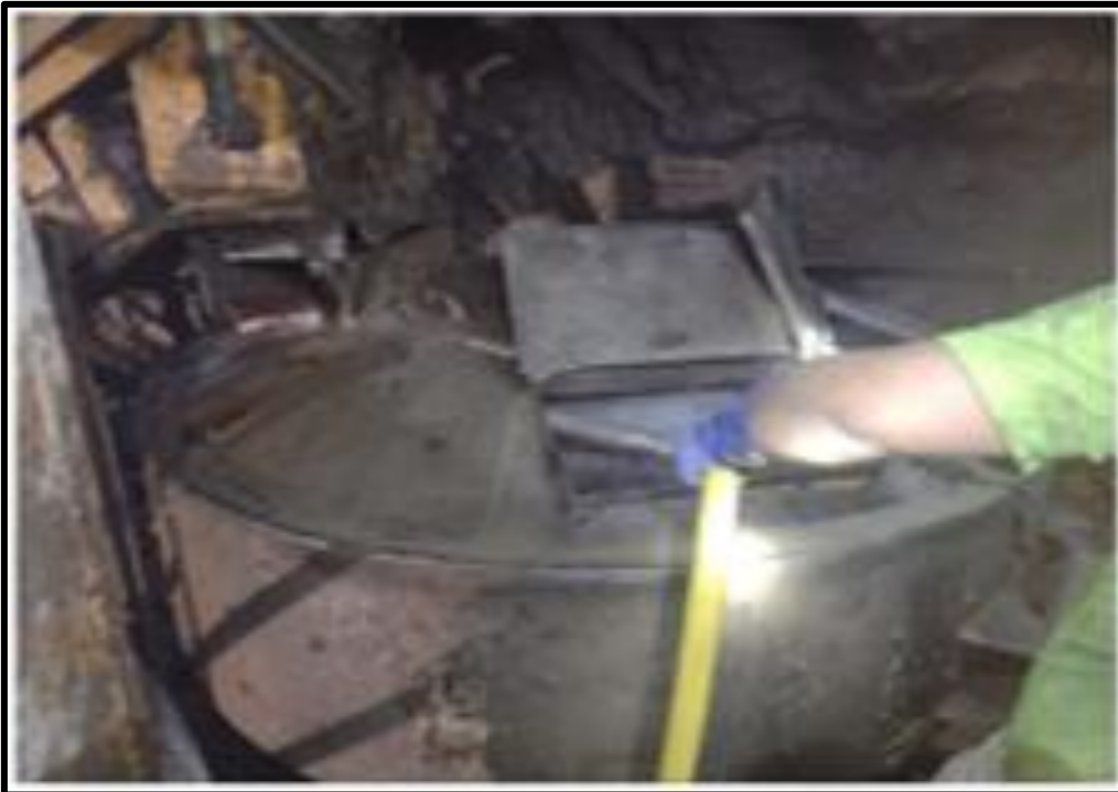
Fotografía 6. Lavado y limpieza de mezclador de shotcrete tipo planetario
