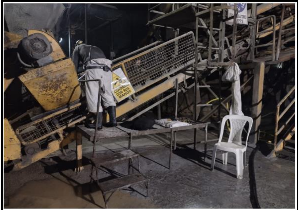
Fotografía 4. Banda transportadora de agregado
