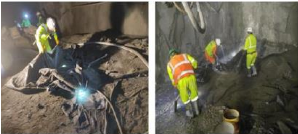
Figura 35. Manta para recolectar el rebote del shotcrete.
