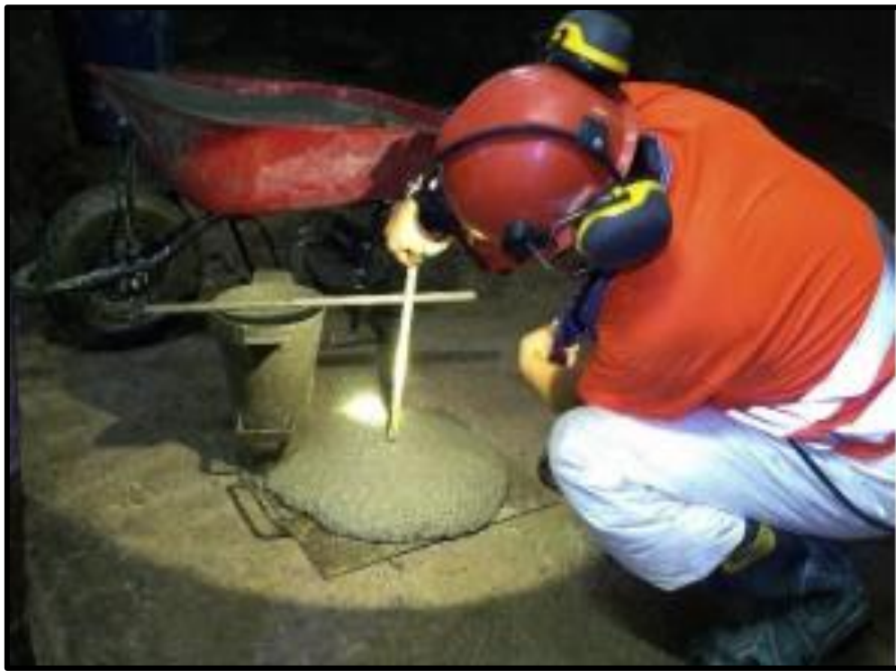
Fotografía 10. Medición de asentamiento del shotcrete
