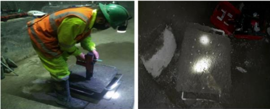
Figura 31. Martillo hilti DX 450 perforando clavos en el panel trapezoidal. Fuente: Elaboración propia.
