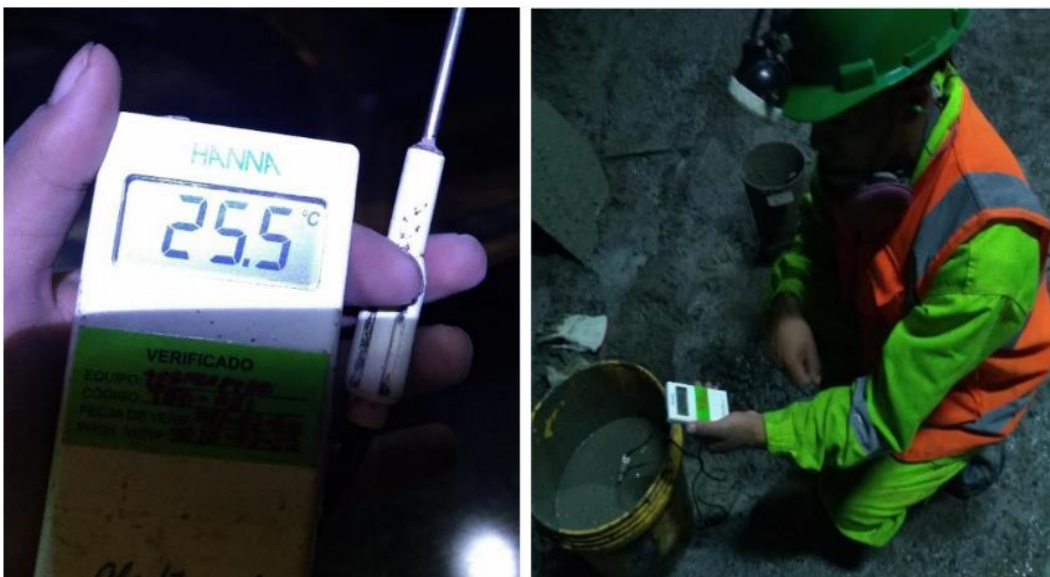
Figura 20. Ensayo para medir la temperatura del shotcrete Fuente: Elaboración propia.
