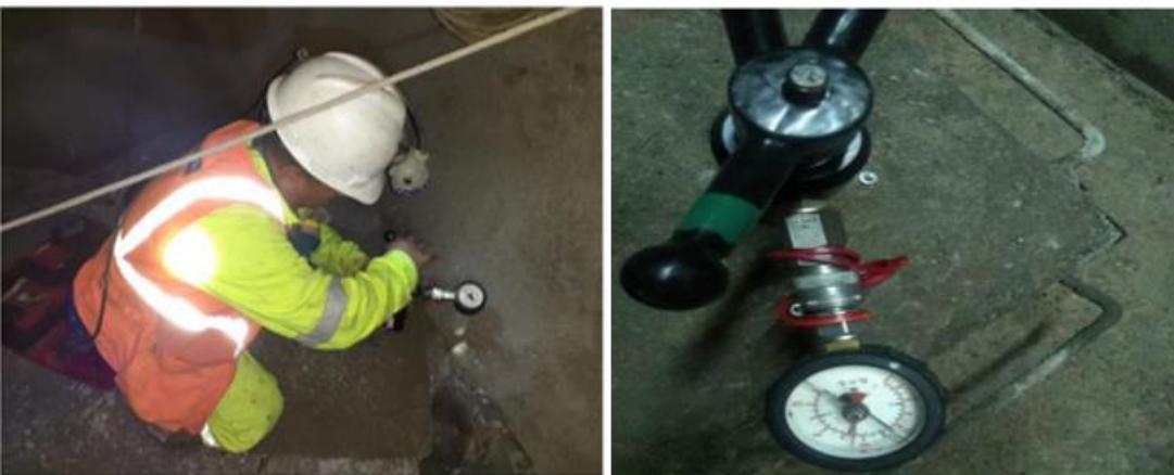
Figura 32. Extracción de los clavos con el equipo Pull-test. Fuente: Elaboración propia.
