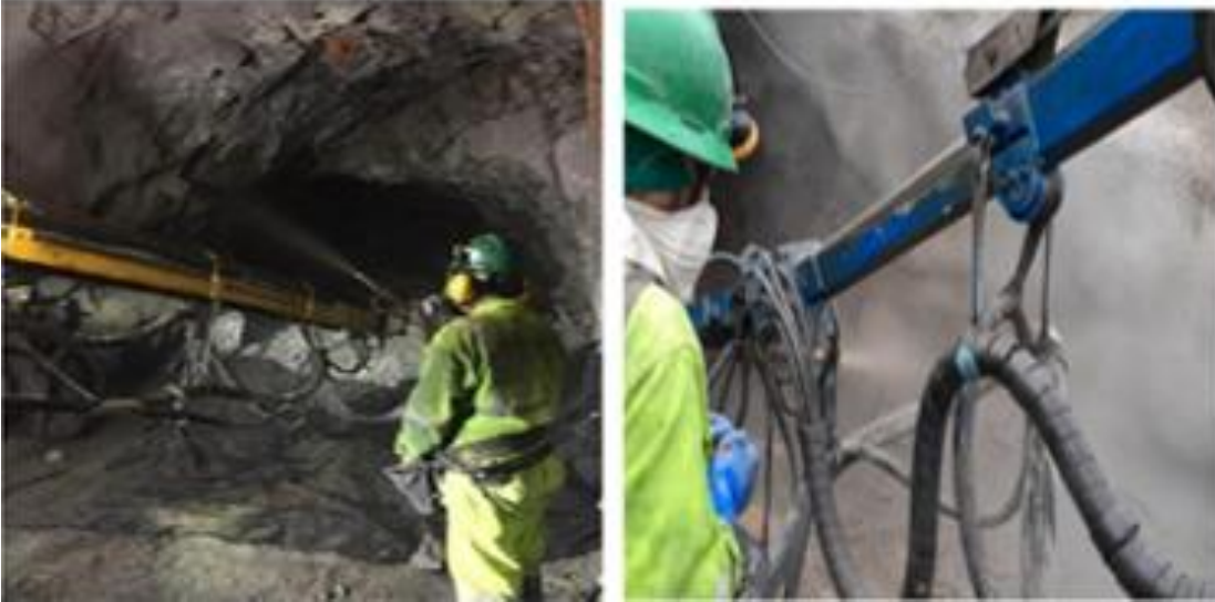
Figura 34. Lanzado de shotcrete en la rampa principal del nivel 21 Fuente: Elaboración propia.
