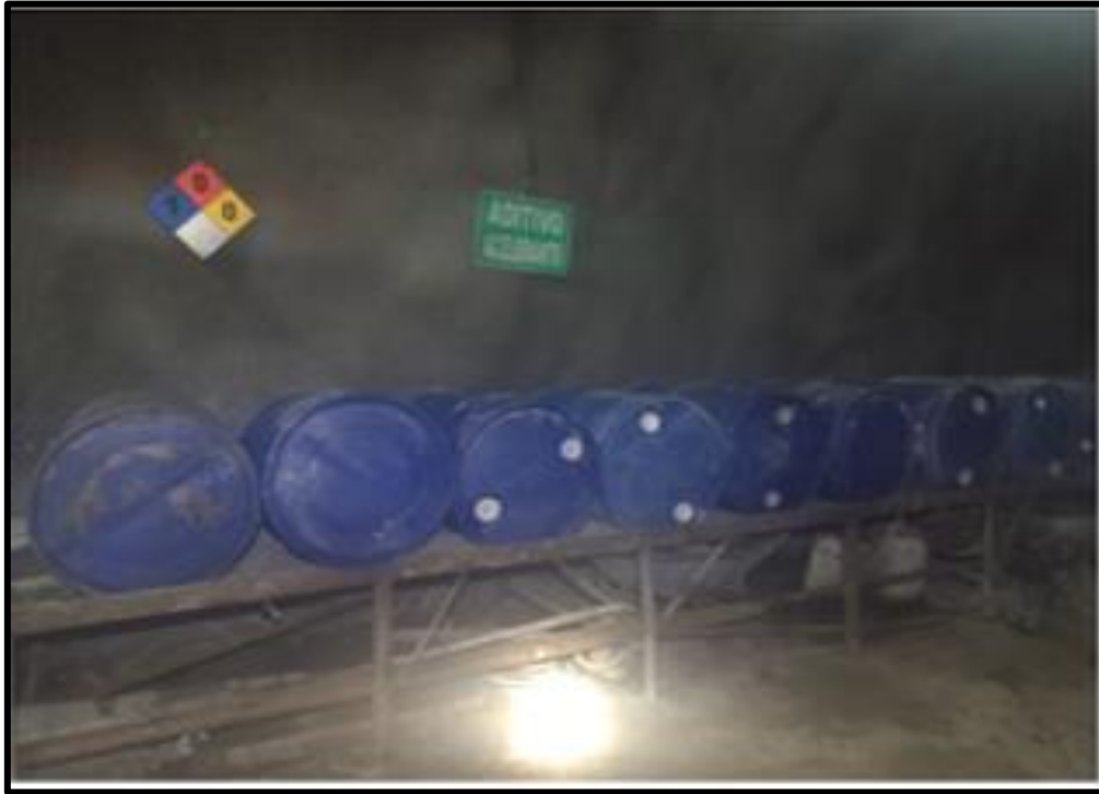
Fotografía 7. Almacenamiento de aditivo acelerante
