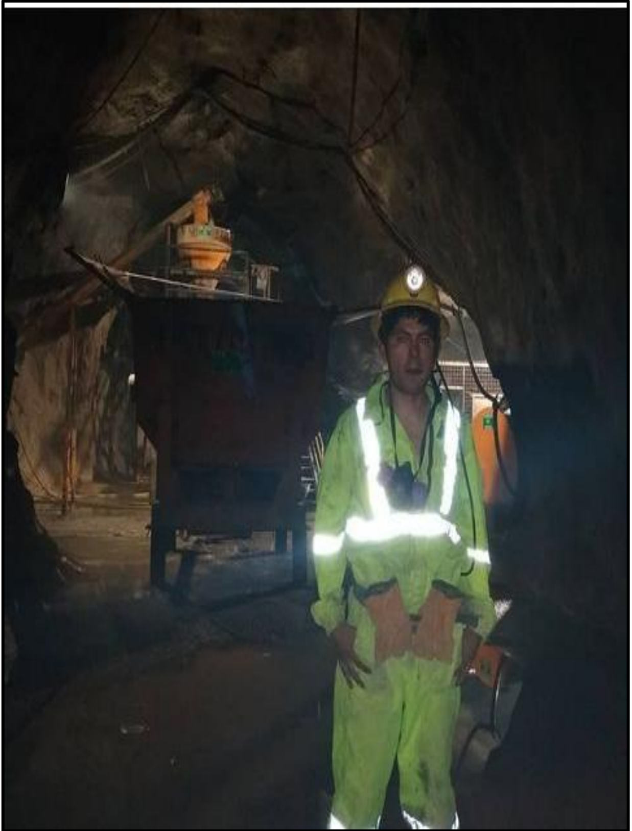
Figura 15. Planta dosificadora de shotcrete en nivel 14 – interior mina
