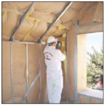
Referencia de instalación de Lana de vidrio
