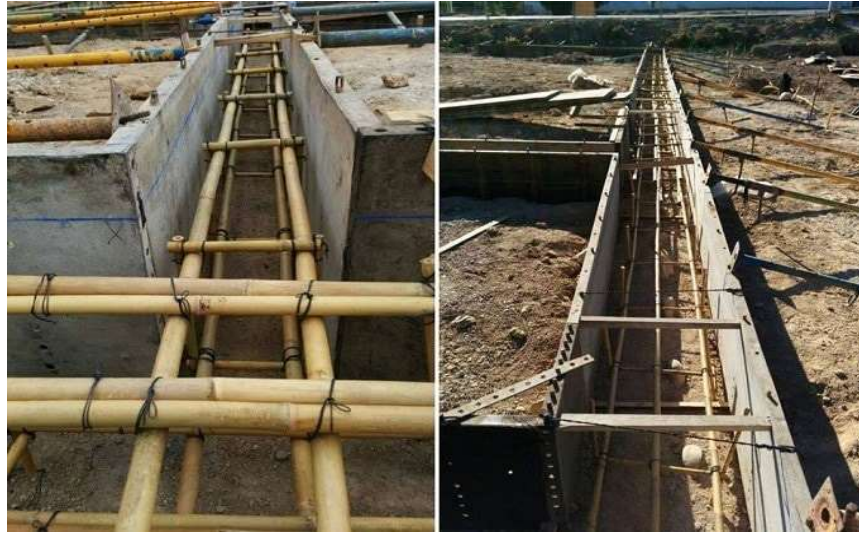
Figura 7: Colocado de bambú para vigas de cimentación
