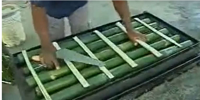
Figura 9: Placa de concreto con bambú para paredes, de 1.00 m x 0.50 m.
