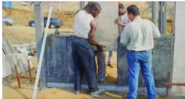
Figura 11: Colocación artesanal de placas de bambú en paredes.
