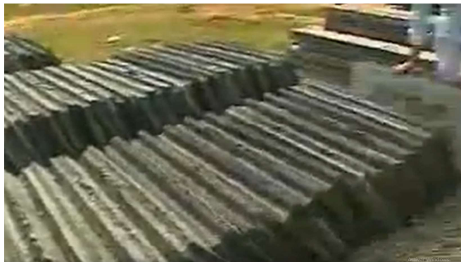
Figura 10: Acopio de placas de bambú reforzado con concreto para paredes.
