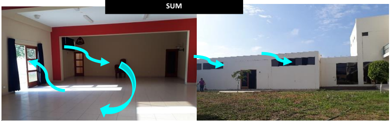
El sumo cuenta con ventanas altas que permiten la ventilación natural el ambiente. Se aprecia una fachada exterior con las ventanas por donde ingresa la ventilación.
