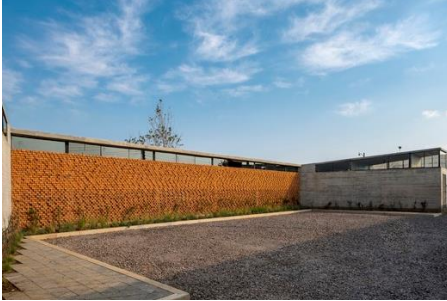
Uso del ladrillo como piel de recubrimiento de la fachada conjuntamente con la textura de la piedra.
