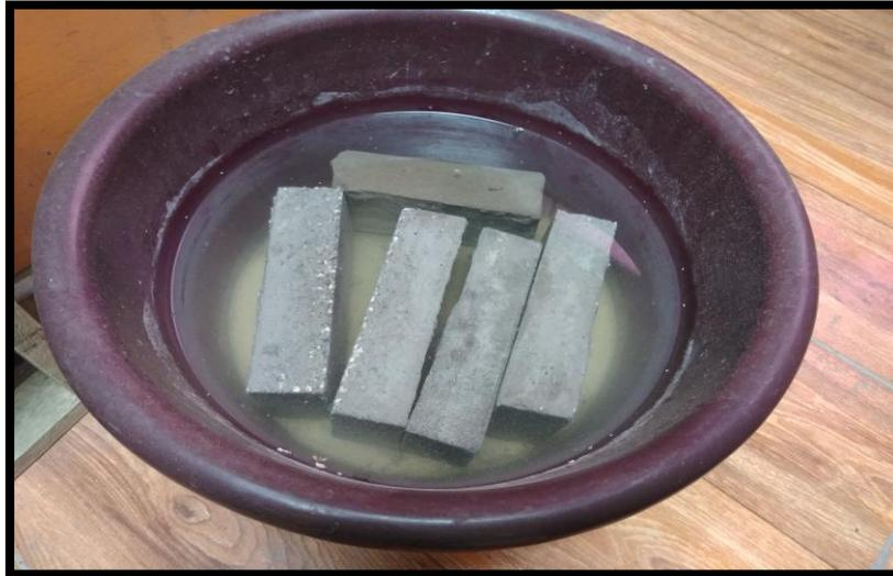
**Figura N°12. Curado de los adoquines**
