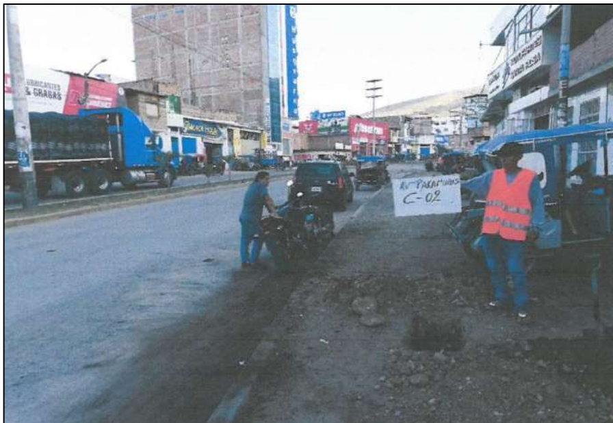
Figura 8. Vista panorámica de la calicata N° 02
