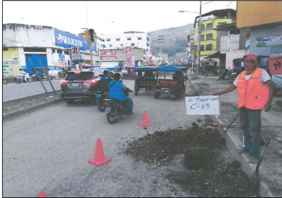
Figura 9. Vista panorámica de la calicata N° 03
