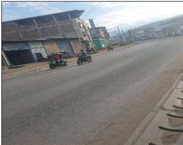
Figura 13. Desprendimiento de agregado tramo 0+000 - 0+045
