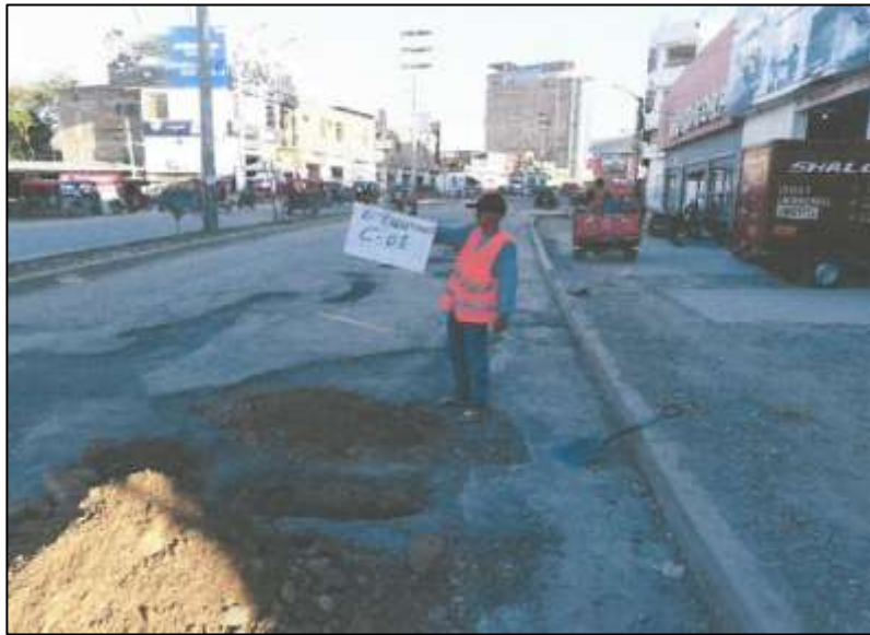
Figura 7. Vista panorámica de la calicata N° 01
