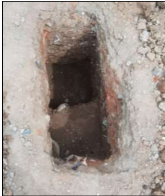
Figura 12. Vista de calicata N° 06
