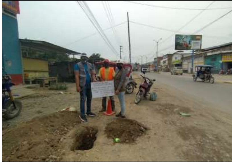
Figura 11. Vista panorámica de la calicata N° 05
