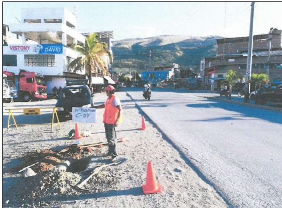
Figura 10. vista panorámica de la calicata N° 04
