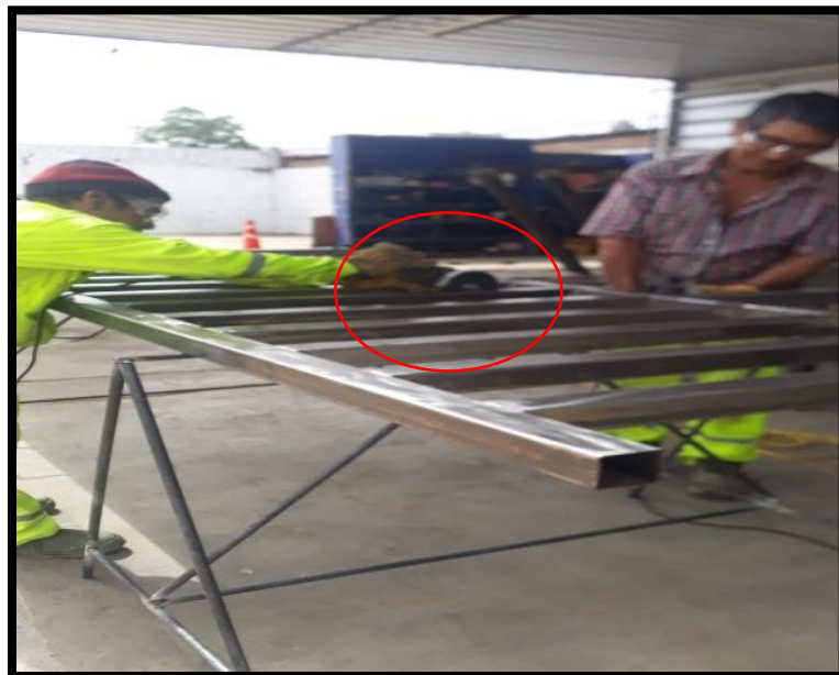
Figura 16. Tratamiento superficial de barandas
