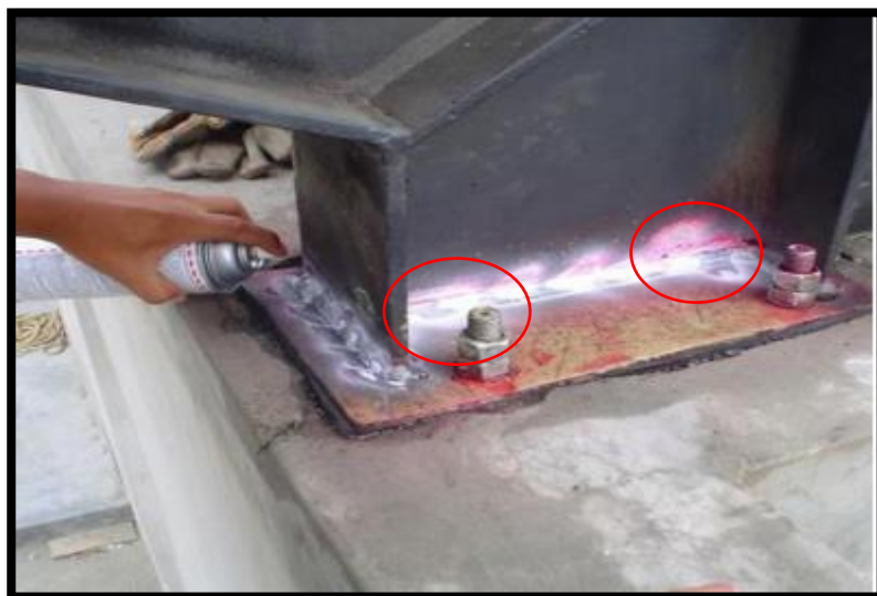
Figura 15. Soldeo de estructura en bases
